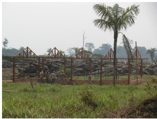
Figura 4. Vista geral da construção do recinto 3 para pequenos mamíferos.
