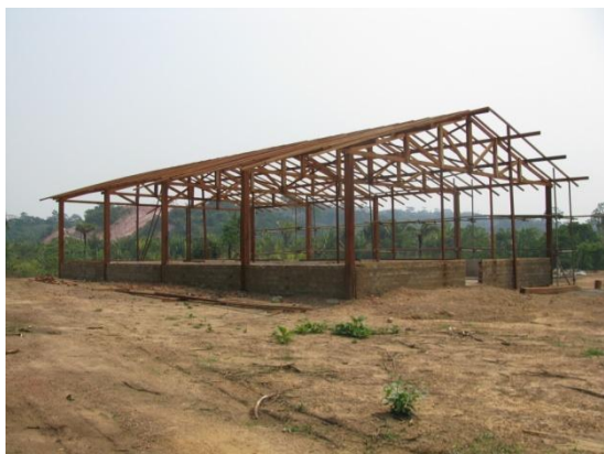
Figura 3. Vista geral da construção do recinto 2 para répteis e anfíbios.
