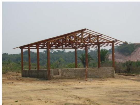
Figura 2. Vista geral da construção do recinto 1 para carnívoros.
