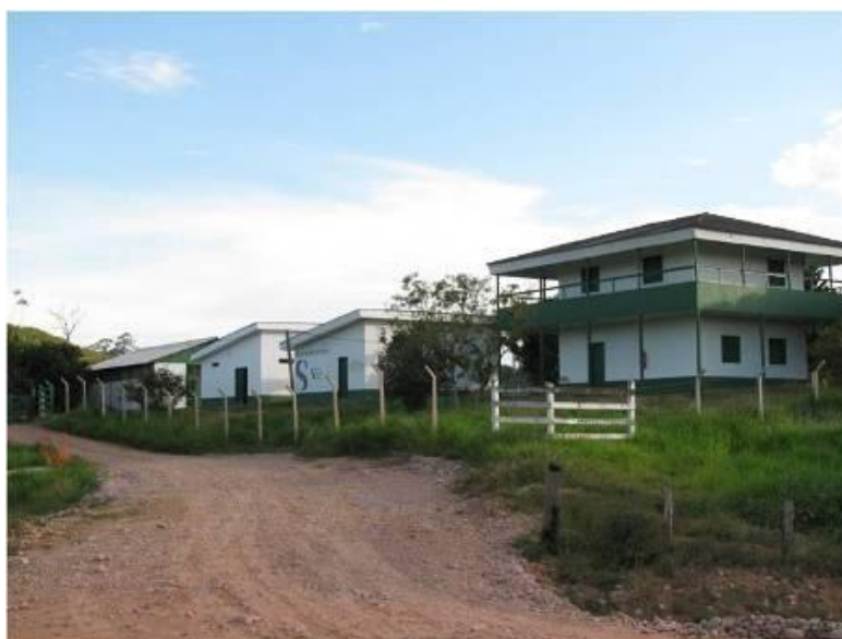
Figura 1. Vista geral da Base de Resgate Provisória.
