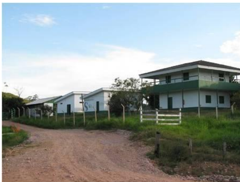
Figura 1. Vista geral da Base de Resgate Provisória.
