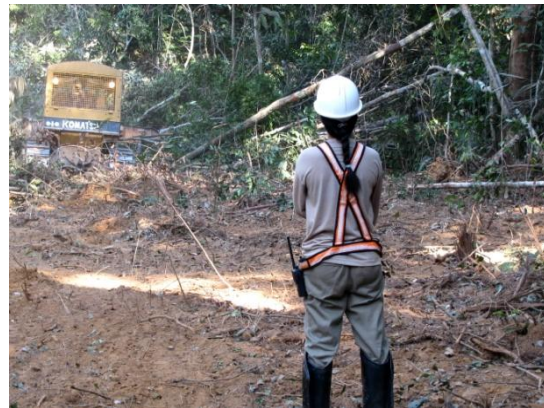
Acompanhamento das atividades de supressão da vegetação na margem esquerda.
