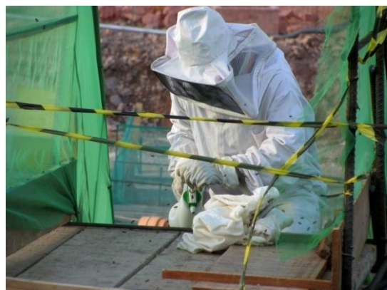
Utilização de spray de água na captura do enxame migratório de Apis mellifera na área do vertedouro.
