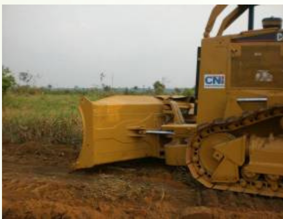
Foto 07 – Abertura da estrada temporária de acesso na área do plantio.
