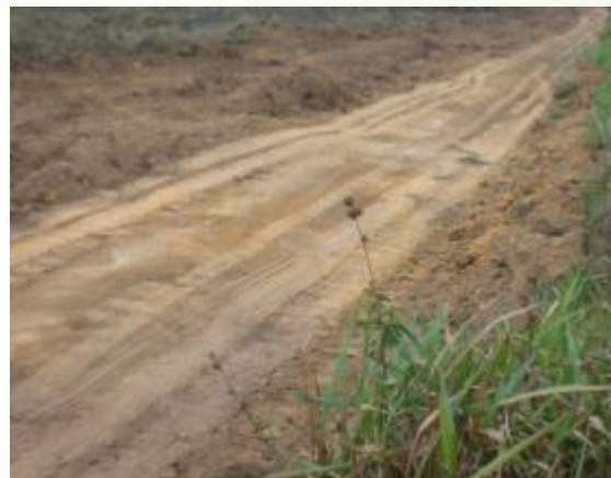
Foto 08 – Estrada Temporária de acesso finalizada.
