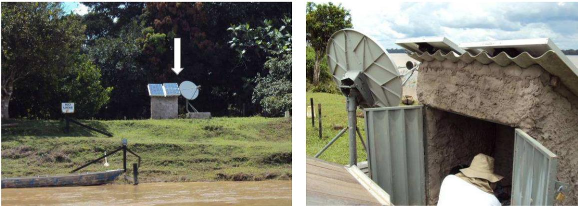
**Figura 47.** Painéis solares, antena de transmissão e abrigo de alvenaria do sistema de monitoramento em tempo real instalados na proximidade da margem do rio Madeira (RS 3 - Lucas).
