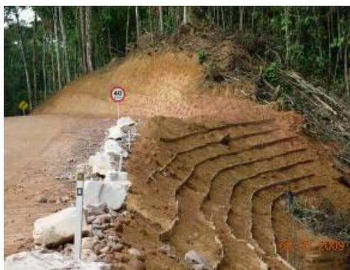
Foto 4.13.1 - Estabilização de talude
