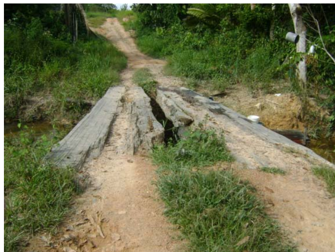
Foto 1 - Ponte de Madeira 1
