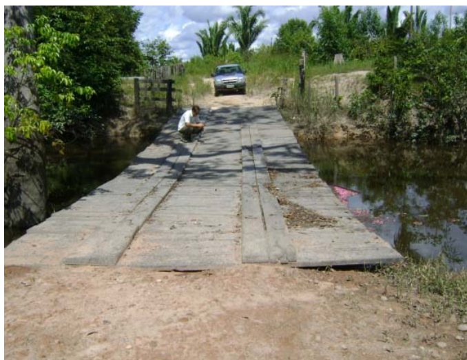
Foto 8 – Ponte de Madeira 4
