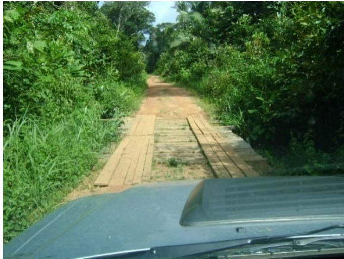
Foto 5 - Ponte de Madeira 6
