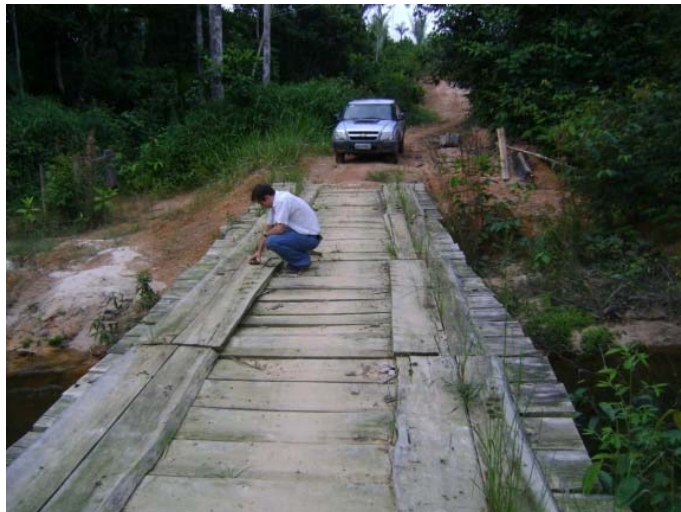
Foto 3 - Ponte de Madeira 4
