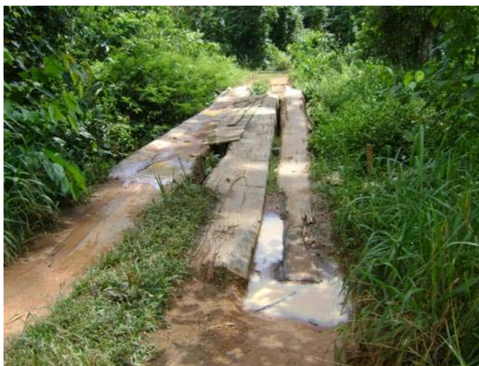
Foto 10 - Ponte de Madeira 11
