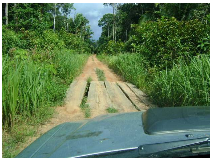
Foto 4 - Ponte de Madeira 5
