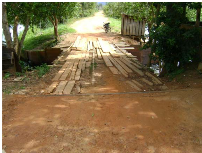
Foto 9 - Ponte de Madeira – Acesso ao Ramal do Vai Quem Quer
