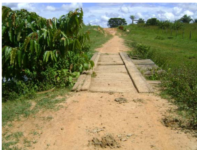
Foto 7 - Ponte de Madeira 3
