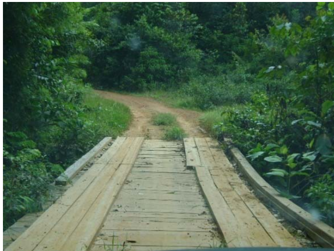
Foto 6 - Ponte de Madeira 7
