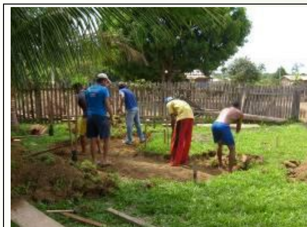
Foto 14 - Construção da Lagoa de Fertilizantes
