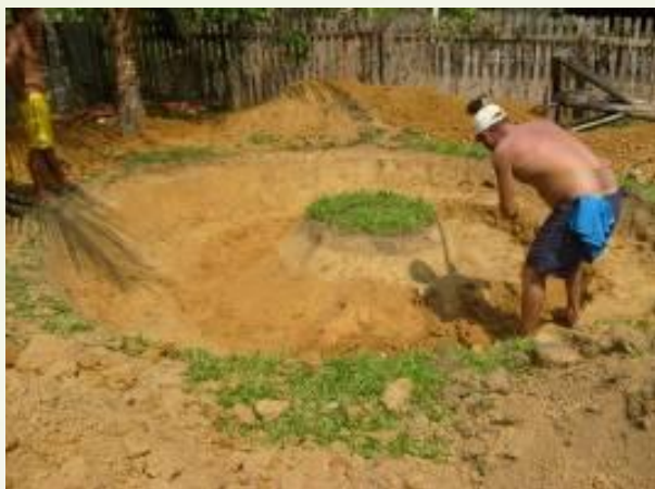
Foto 57 - Construção da lagoa de Fertilizante
