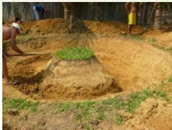
Foto 57 - Construção da lagoa de Fertilizante
