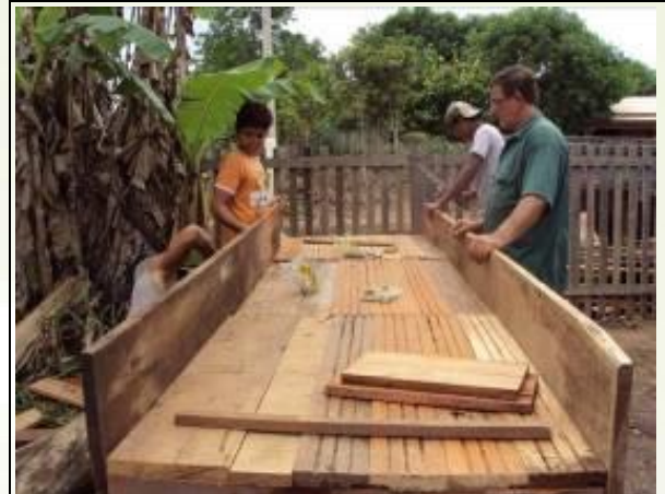
Foto 80 - Construção do minhocário
