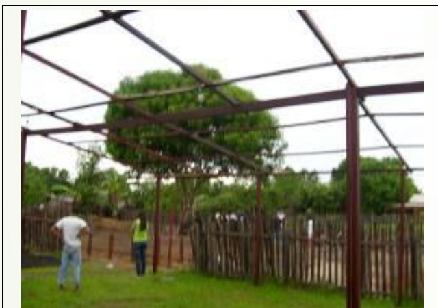
Foto 13 - Ampliação da Área Coberta
