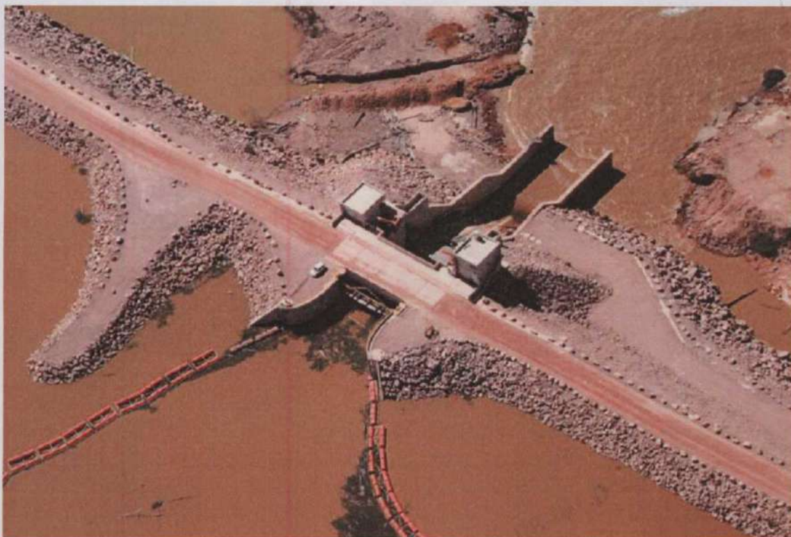
Fig. 4 – Vista superior do sistema descarregador de troncos.
