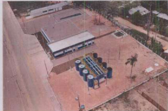
Foto 02 – Sistema de Abastecimento de água Jaci Paraná.
