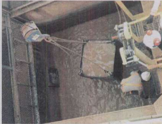
Figura 34: Operação do STP da margem direita de UHE Jirau.
