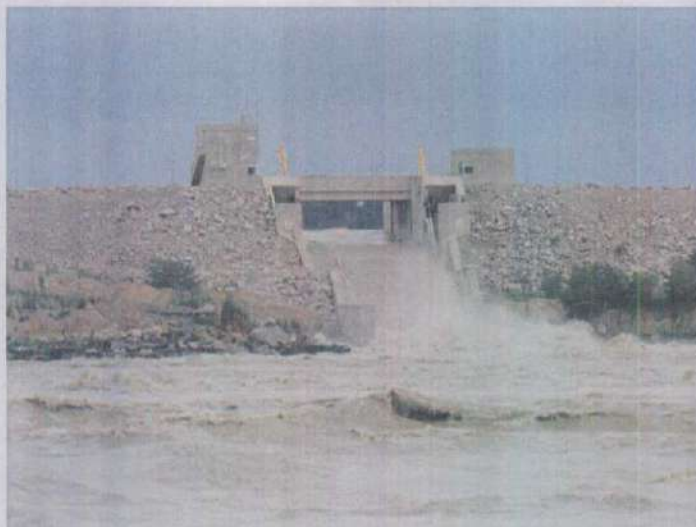
Figura 40: Vertedouro do Sistema de Transposição de Troncos da UHE de Jirau. Margem esquerda.
