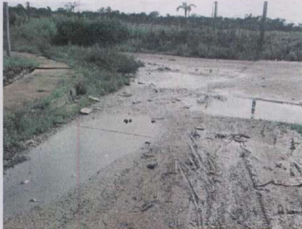
Figura 26: Esgoto a céu aberto nas Ruas de Nova Mutum Paraná-RO.
