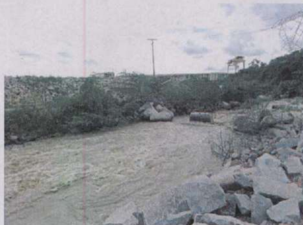
Figura 3: Sistema de Transposição de Peixes da UHE Santo Antônio.
