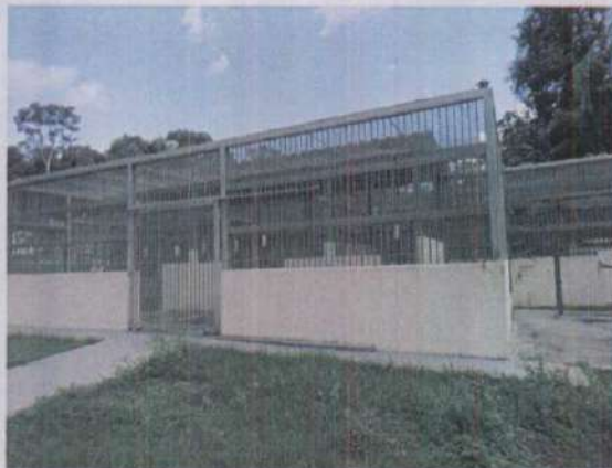
Figura 59: Recinto para grandes felinos. CETAS da UHE Santo Antônio.
