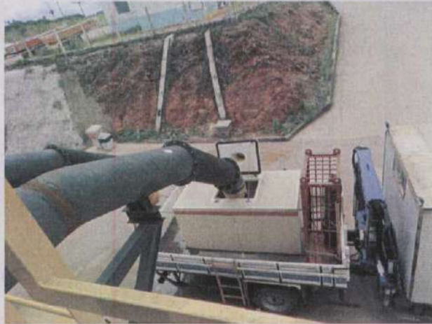
Figura 37: Transferência dos peixes capturados pela STP da margem direita da UHE de Jirau para um caminhão-tanque.
