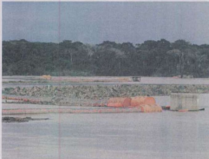
Figura 14: Boia de contenção do Sistema de Transposição de Troncos da UHE de Santo Antônio.
