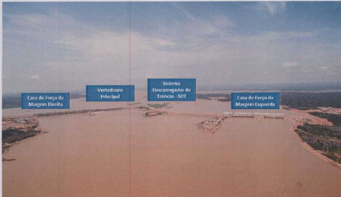
Fig. 2 - Estrutura da usina.
