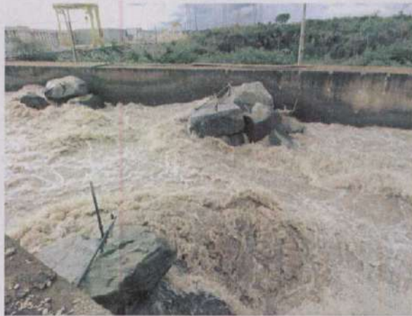
Figura 2: Sistema de Transposição de Peixes da UHE Santo Antônio.
