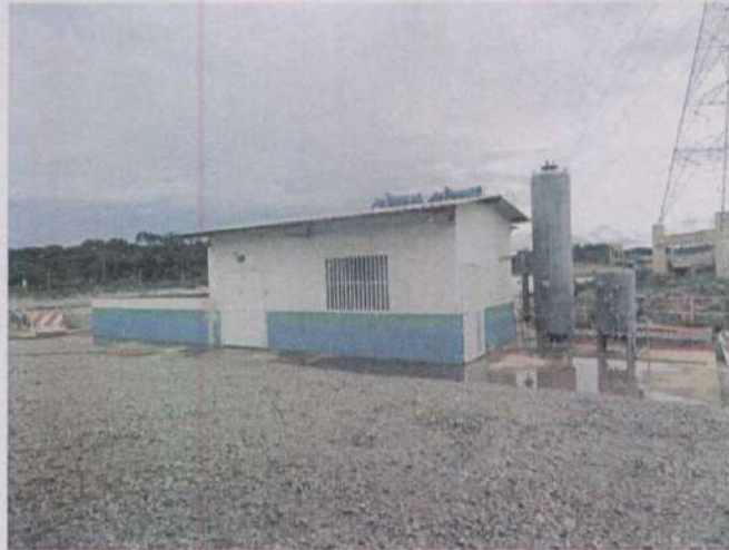
Figura 13: Pequena Estação de Tratamento de Água. Laboratório de Reprodução de Peixes da UHE Santo Antônio.
