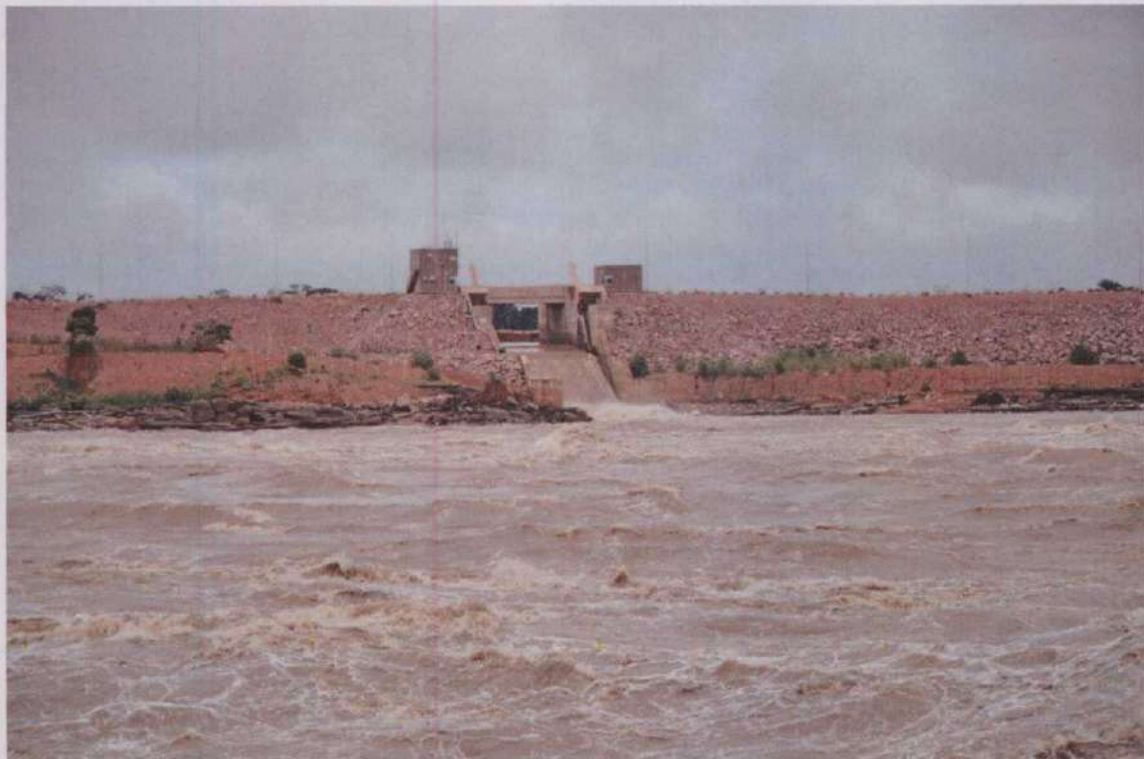
Fig. 3 - Sistema descarregador de troncos.
