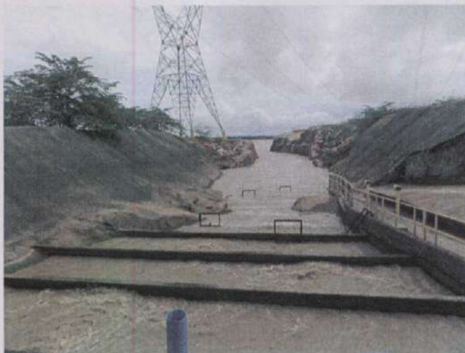
Figura 31: Rampa de acesso ao STP de Jirau da margem direita.
