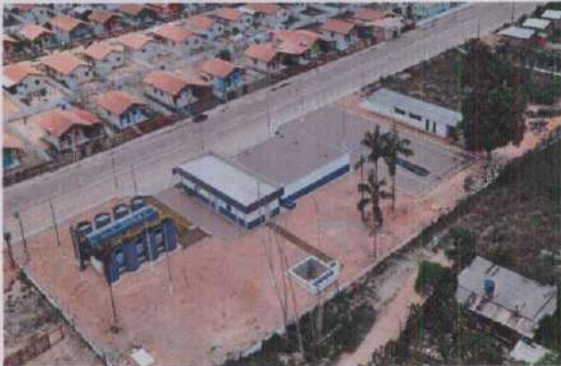
Foto 01 – Sistema de Abastecimento de água Jaci Paraná.
