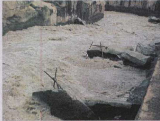
Figura 1 Sistema de Transposição de Peixes da UHE Santo Antônio.
