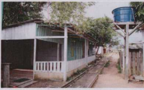
As primeiras residências de Jacy-Paraná passaram a ser abastecidas com água tratada nesta terça (22), após inauguração da unidade de tratamento do distrito
