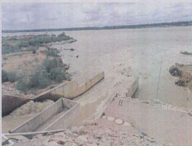
Figura 41: Vertedouro do Sistema de Transposição de Troncos da UHE de Jirau. Margem esquerda.
