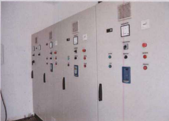
Foto 11 – Sistema de Abastecimento de água.
