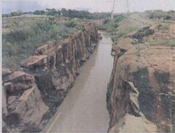
Figura 4: Sistema de Transposição de Peixes da UHE Santo Antônio.
