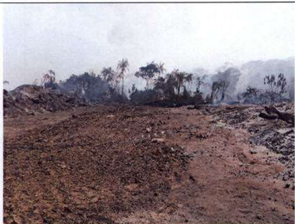
Foto 07: Evidências do aceiro realizado no dia 19/07/16 e focos de incêndios no entorno da área – Pátio P2A2B01.
