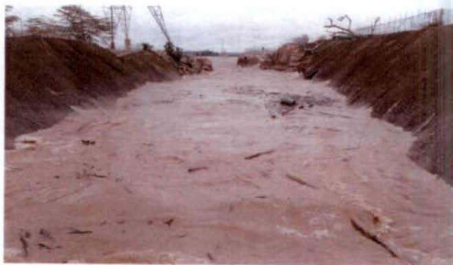
Foto 1 – Níveis d'água no STP escavado.
