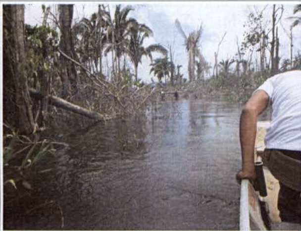
Foto 15. Igarapé 30 – ponte submersa.
