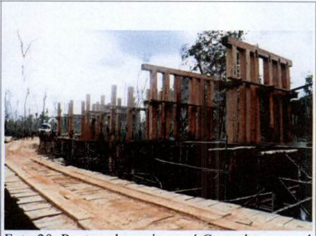
Foto 20. Ponte sobre o igarapé Castanho – ramal Santo Antônio (imagem fornecida pela ASPRECAM).
