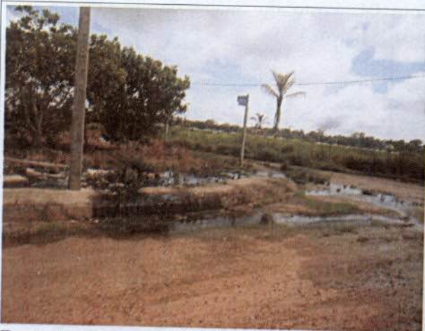
Foto 11. Sistema de saneamento - Nova Mutum Paraná.
