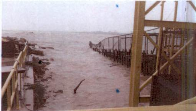
Foto 2 - Níveis d'água no STP metálico.
