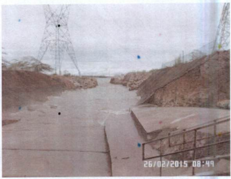
Foto 1 – Situação do STP escavado em 26 de fevereiro de 2015.
