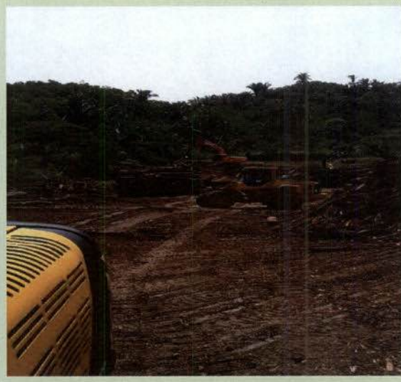
Foto 24: Empilhamento do material relocado internamente - P1A02-MD.
