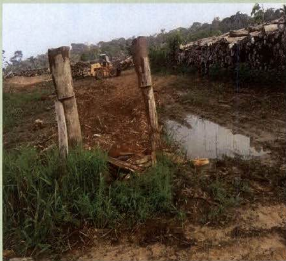
Foto 21: Relocação de pilhas de madeira – P1C02-MD.
