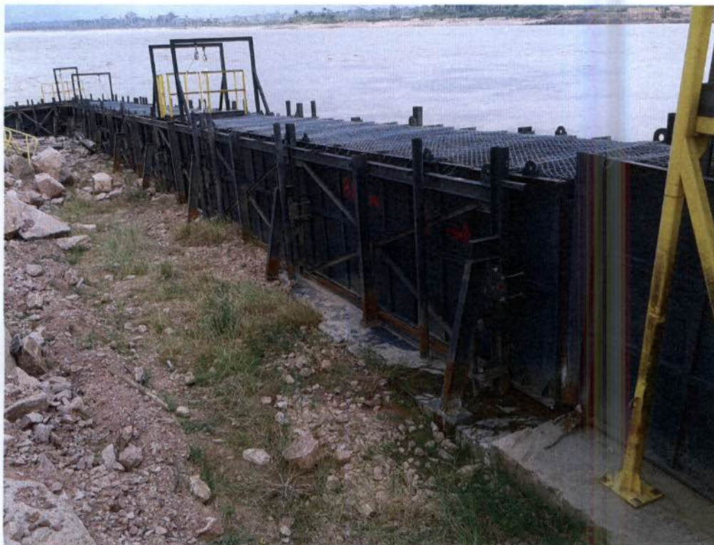
Foto 1: Vedação dos vazamentos ao longo do canal metálico
