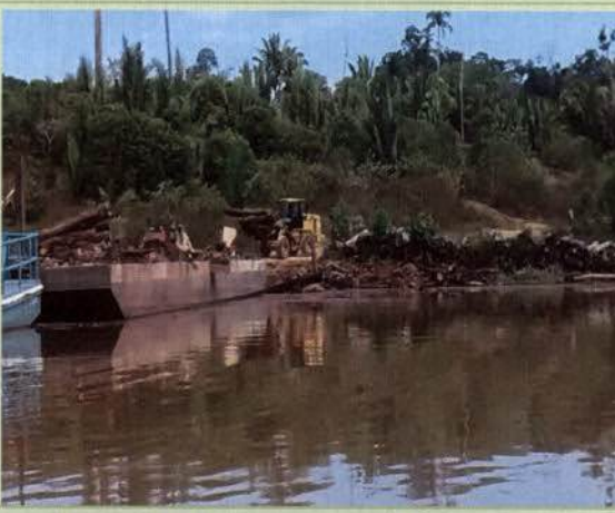
Foto 17: Balsa atracada sendo carregada (relocação externa para o canteiro de obras-MD) - P1A01-MD.
