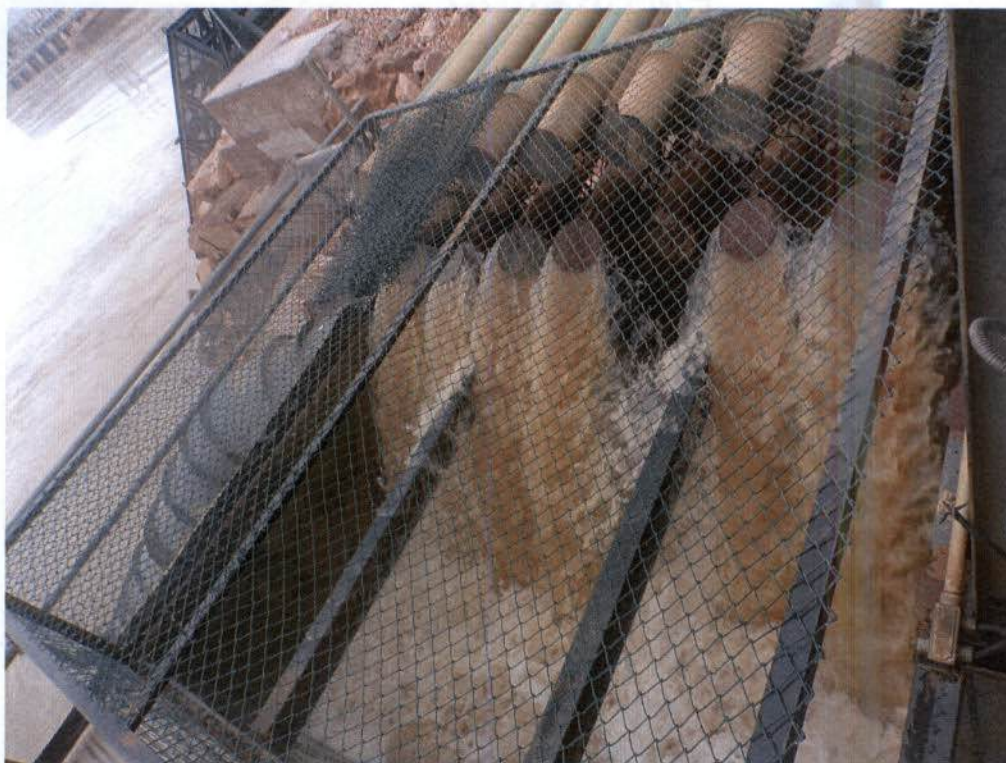
Foto 2: Colocação de tela de proteção no tanque de bombas
