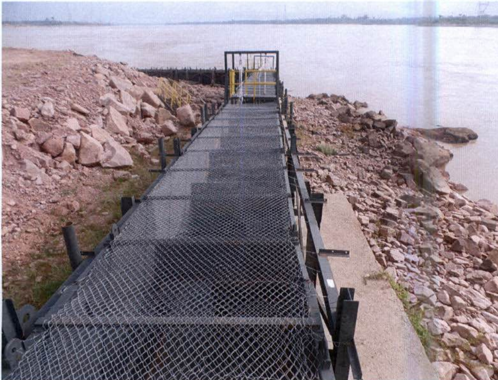
Foto 3: Colocação de tela de proteção no canal metálico
