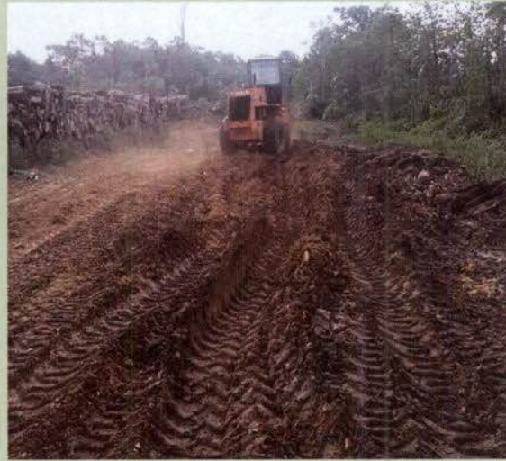
Foto 22: Relocação de pilhas de madeira – P1C02-MD.
