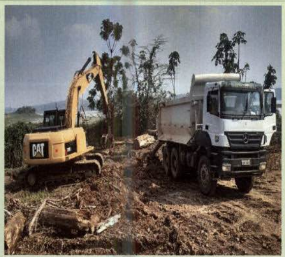
Foto 30: Carregamento de madeira (relocação interna de pilhas) – P5C5D01-ME.
