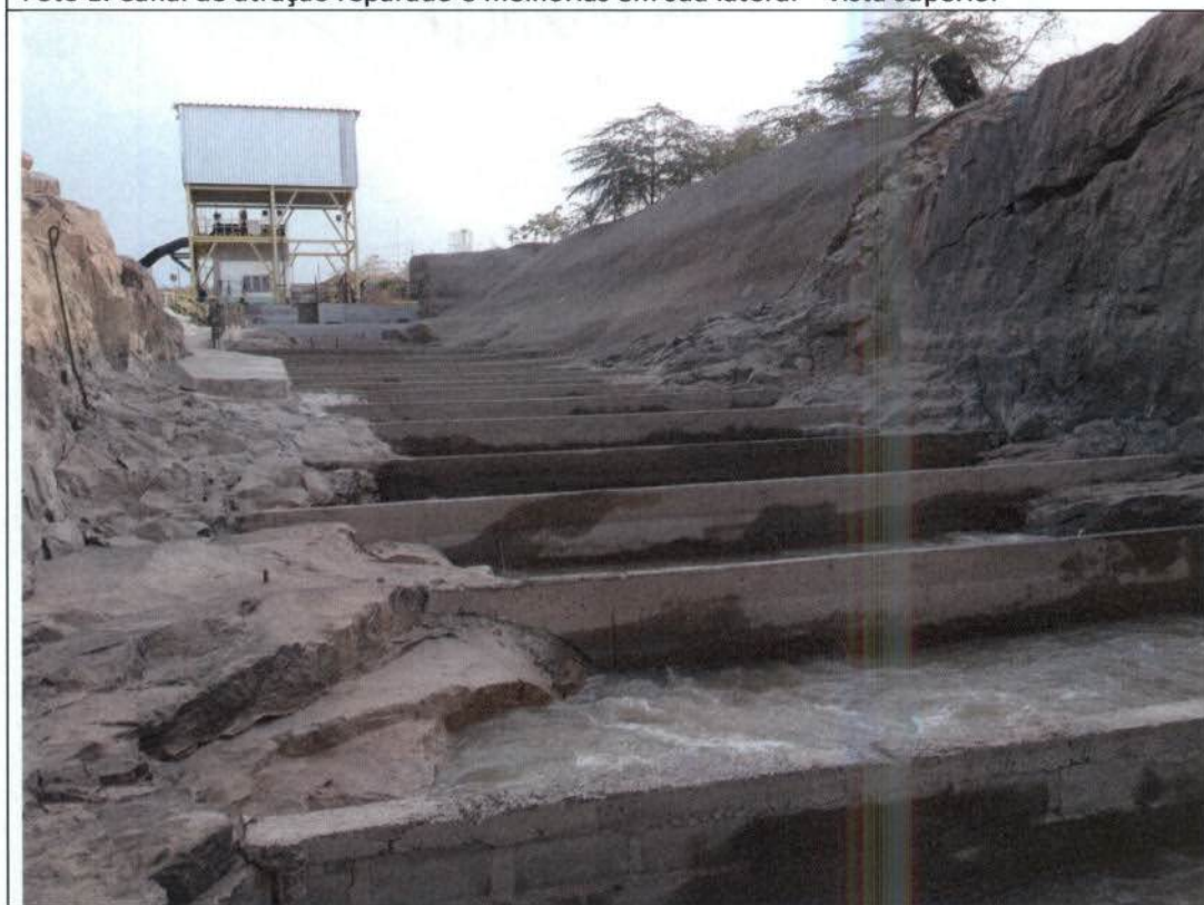
Foto 2: Canal de atração reparado – vista inferior
