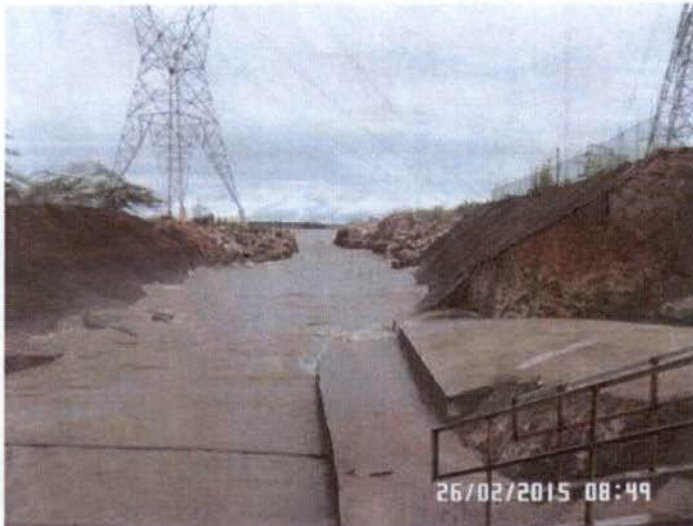
Foto 1 – Situação do STP escavado em 26 de fevereiro de 2015.
