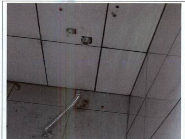
Foto 24 – Pias e torneiras dos banheiros
