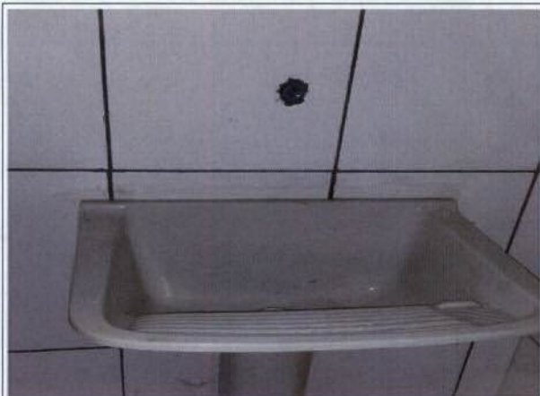
Foto 21 – Torneira em inox do tanque
