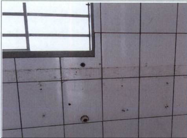
Foto 17 – Torneira em inox e sifão da pia da cozinha
