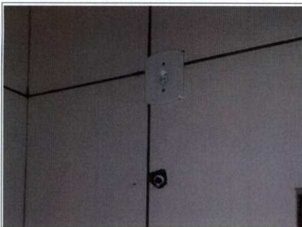
Foto 25 – Chuveiros dos banheiros
