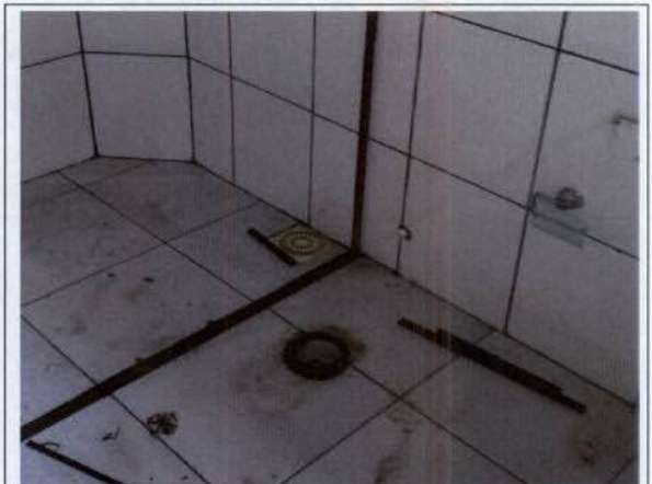
Foto 22 – Vasos sanitários dos banheiros
