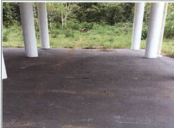
Foto 03 – Marcas de pneus de veículo na varanda do PV.
