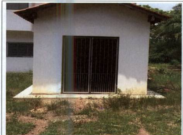
Foto 04 – Marcas de pneus de veículo próximo à casa de força.
