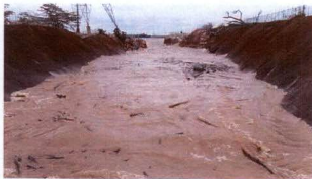
Foto 1 – Níveis d'água no STP escavado.
