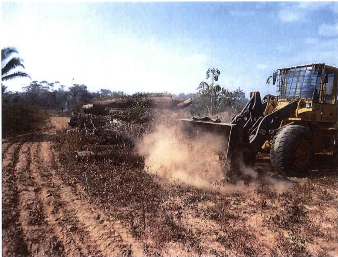
Reforçando área de aceiro no entorno das pilhas remanescentes
