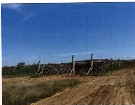
Foto 6: Aceiro executado no pátio P2D-01
