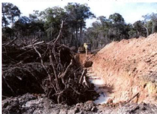
Figura 1.5.2: Abertura de valas para enterrio.
