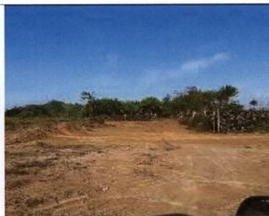
Foto 4: Aceiro executado no pátio P1F-04
