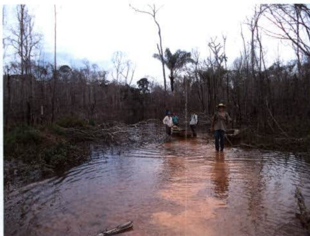
Foto 01: Trecho da ponte do rio Castanho no período de altas vazões
