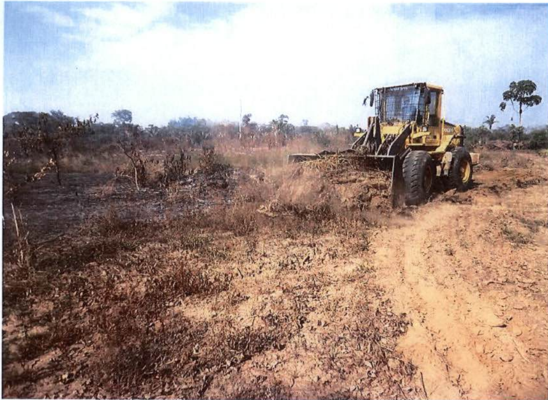
Aumentando da área de segurança de aceiro para defesa das pilhas de madeiras remanescentes
