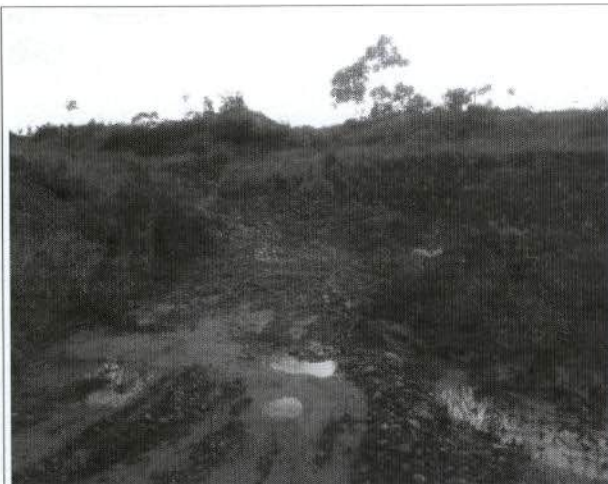
Foto 31. Escoamento de água em um dos taludes na área de PRAD dos lotes 1A,1B, 1C e 1D em Nova Mutum Paraná.
