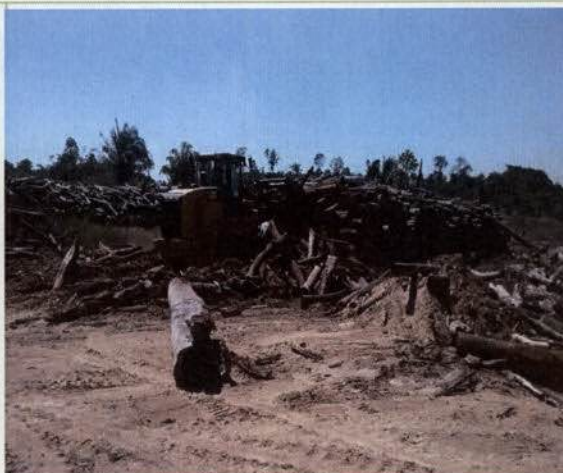
Foto 02: Atividade de remoção de pilha de madeira – P2A2B01-MD.
