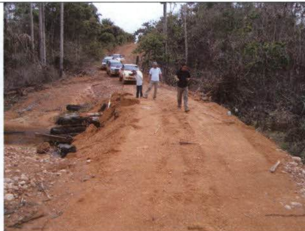
Figura 02: Foto digital com analistas testando a estrutura sobre corpo hídrico na estrada de acesso ao pátio P1B1 (fogo)
