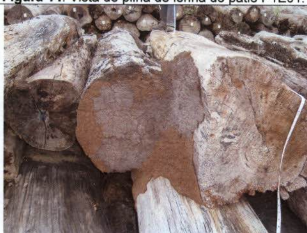
Figura 16: Tora da pilha 96 do pátio P1E01 infestada por cupim com qualidade imprópria para serraria.
