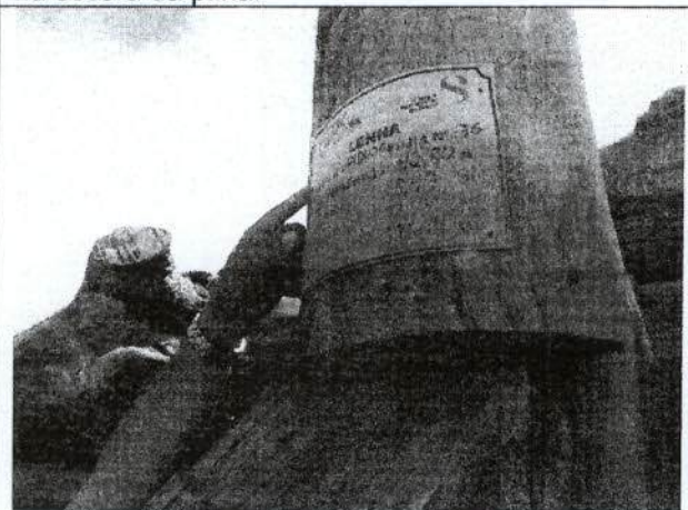
Figura 05: Foto digital de placa da pilha de lenha do pátio P1D02 com marca de linha d'água.
