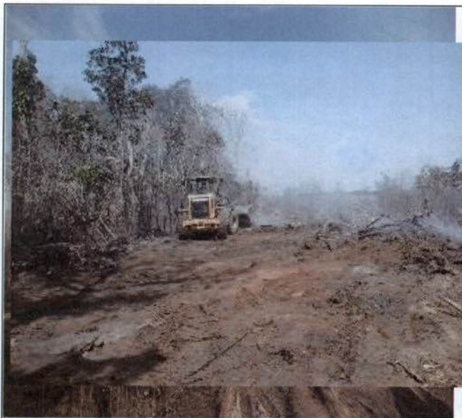
Foto 01: Confecção de um segundo aceiro para impedir o avanço de fogo sobre a Área de Preservação Permanente (APP) – P2B01.
