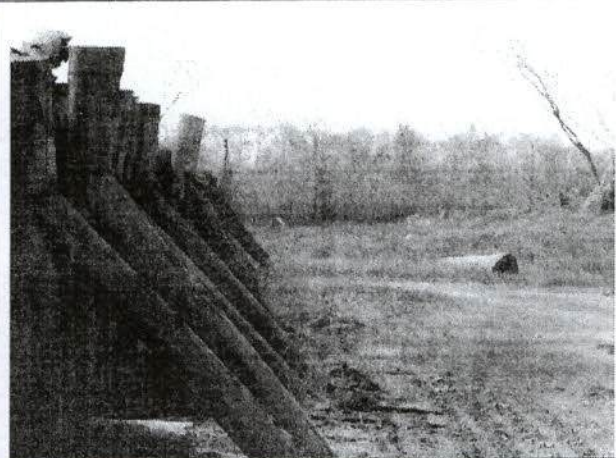
Figura 02: Ao fundo, vista de vestígios da linha de inundação na vegetação do entorno do pátio P1D02.
