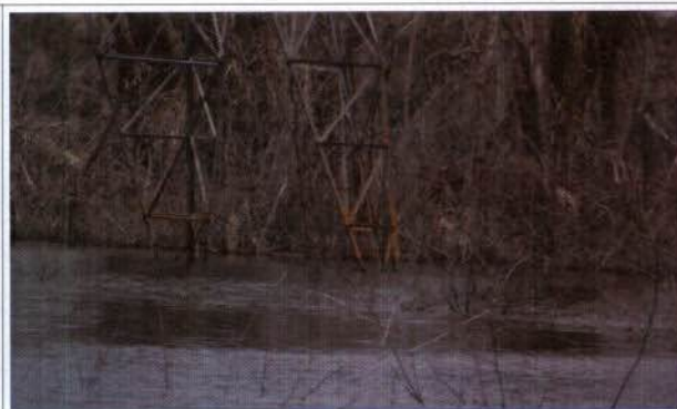
Foto 18. Torres de energia com a base alagada, no rio Mutum-Paraná
