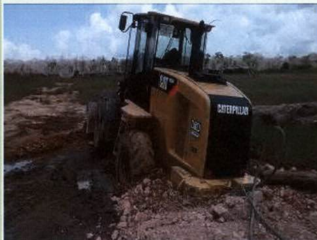
Figura 09: Terreno instável não suportou o peso do maquinário.
