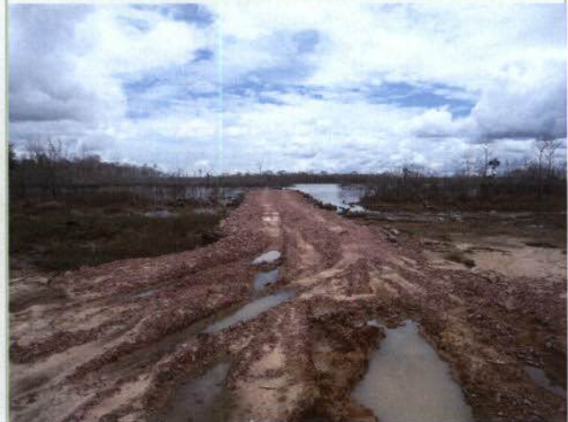
Figura 10: Terreno instável na rampa de descarregamento – P1D01 (Igarapé Caiçara).
