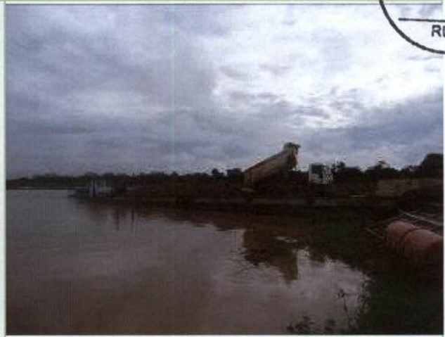
Figura 08: Carregamento de balsa com material rochoso para instalação de um atracadouro próximo ao P1D01 (Igarapé Caiçara).
