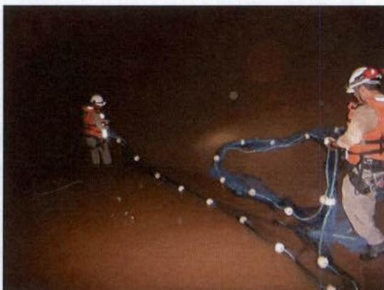
**Figura 1.** Sondagem, com utilização de redes de cerco, no interior do tubo de sucção da UG 29.
