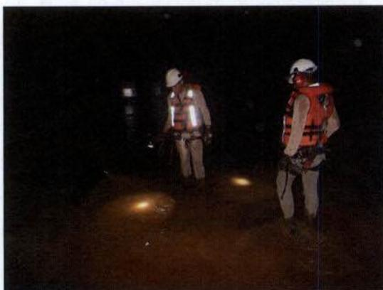
**Figura 1.** Realização de vistoria no interior do tubo de sucção da UG 07.
