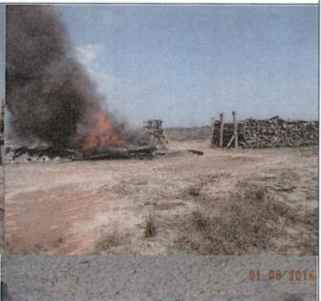
Foto 04: Ação do maquinário impedindo o avanço do fogo sobre as pilhas remanescentes – P2B01.
