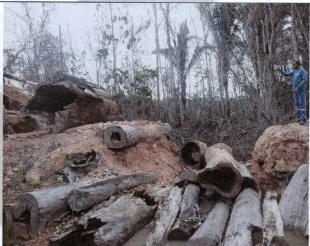
Foto 08: Início dos trabalhos de recuperação da ponte – P1B01.
