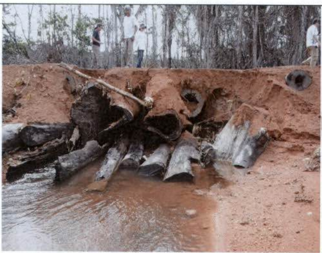
Foto 09: Inserção de toras ocas na manutenção da ponte – P1B01.
