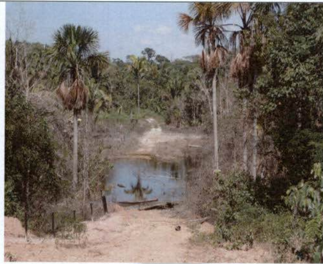
Foto 05: Acesso principal tomado pelos alagamentos (Ponte Submersa) – P1B01.
