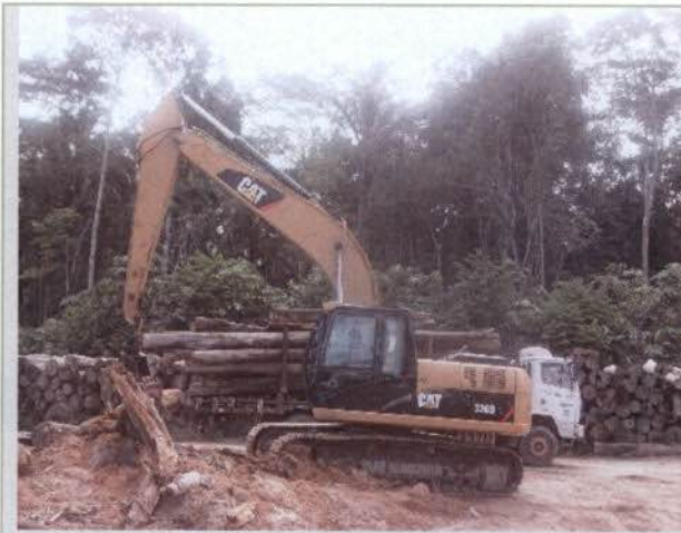
Figura 13: Transporte da madeira provinda do transporte fluvial – P5C5D01.
