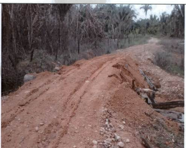
Foto 10: Acesso reestabelecido com a manutenção da ponte – P1B01.
