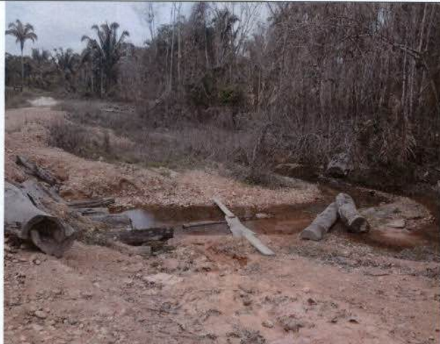
Foto 07: Situação do igarapé após a baixa das águas – P1B01.
