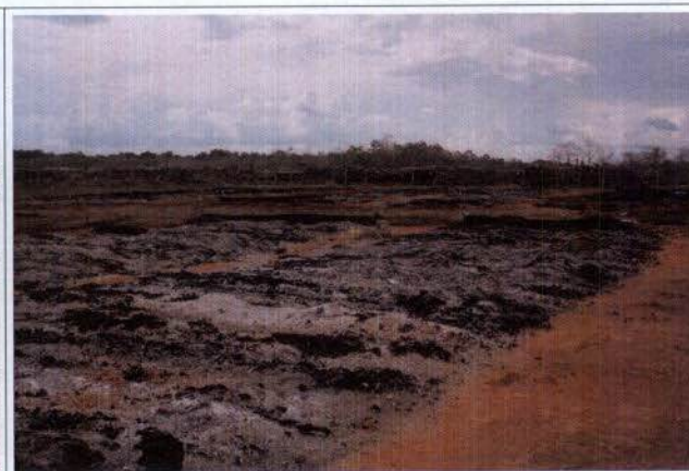
Foto 25: Restos de incêndio lote 2B01
