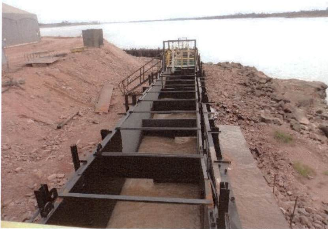
Foto 1: STP metálico em operação.
