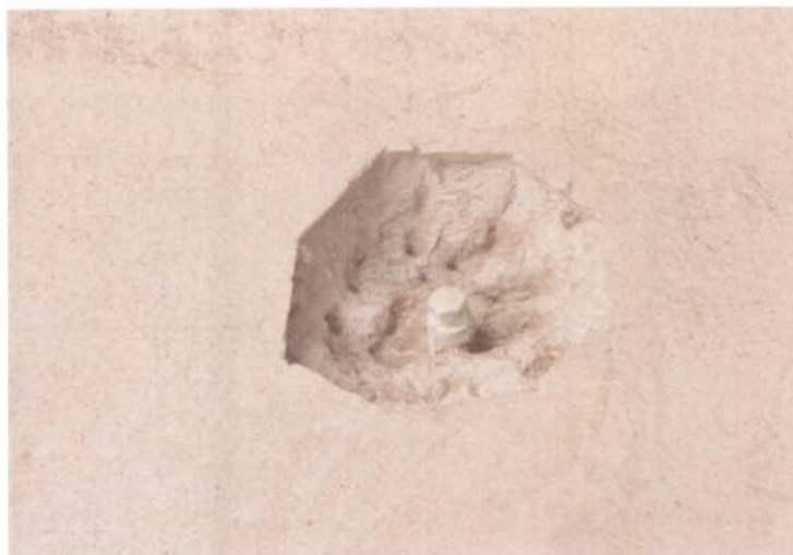
Figura 19. Detalhe de um ponto de insuflação de ar em fase de montagem no tubo de sucção de uma das unidades geradoras da UHE Jirau.
