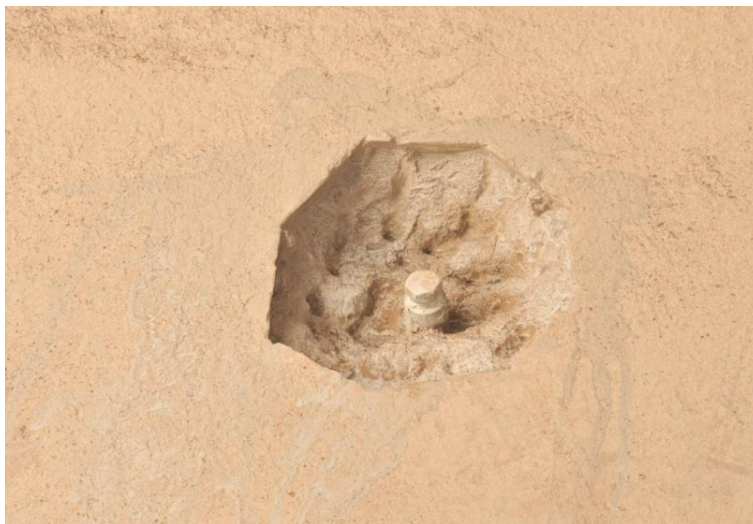
Figura 19. Detalhe de um ponto de insuflação de ar em fase de montagem no tubo de sucção de uma das unidades geradoras do AHE Jirau.
