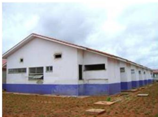
FOTO 2.18. 6: Vista lateral do prédio da enfermaria - Hospital Regional de Cacoal
