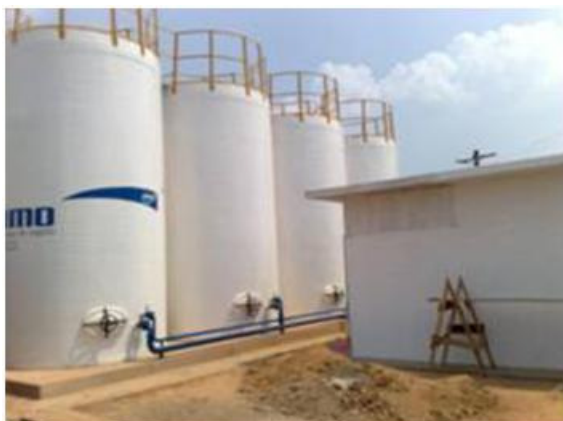
FOTO 2.18. 4: Vista da estação de tratamento de esgoto - Hospital de Base Ary Pinheiro
