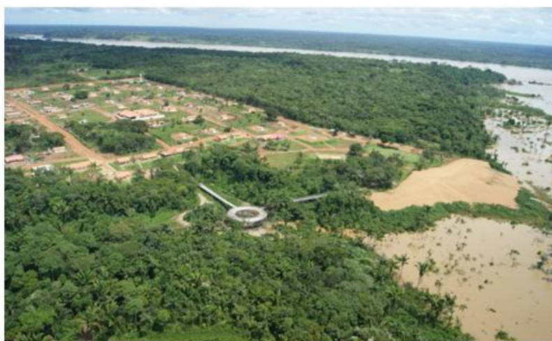
FOTO 2.26. 4: Vista Aérea Vila Nova de Teotônio e Praia - abril de 2011
