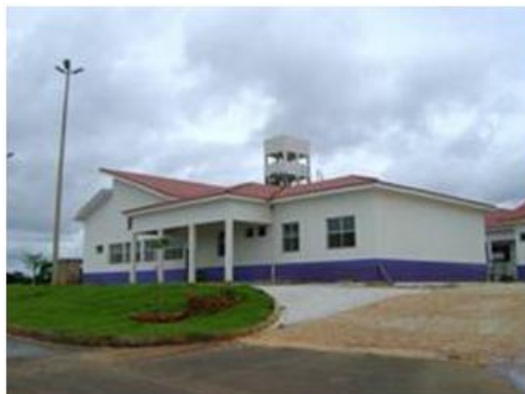
FOTO 2.18. 5: Vista da cozinhas e refeitório - Hospital Regional de Cacoal
