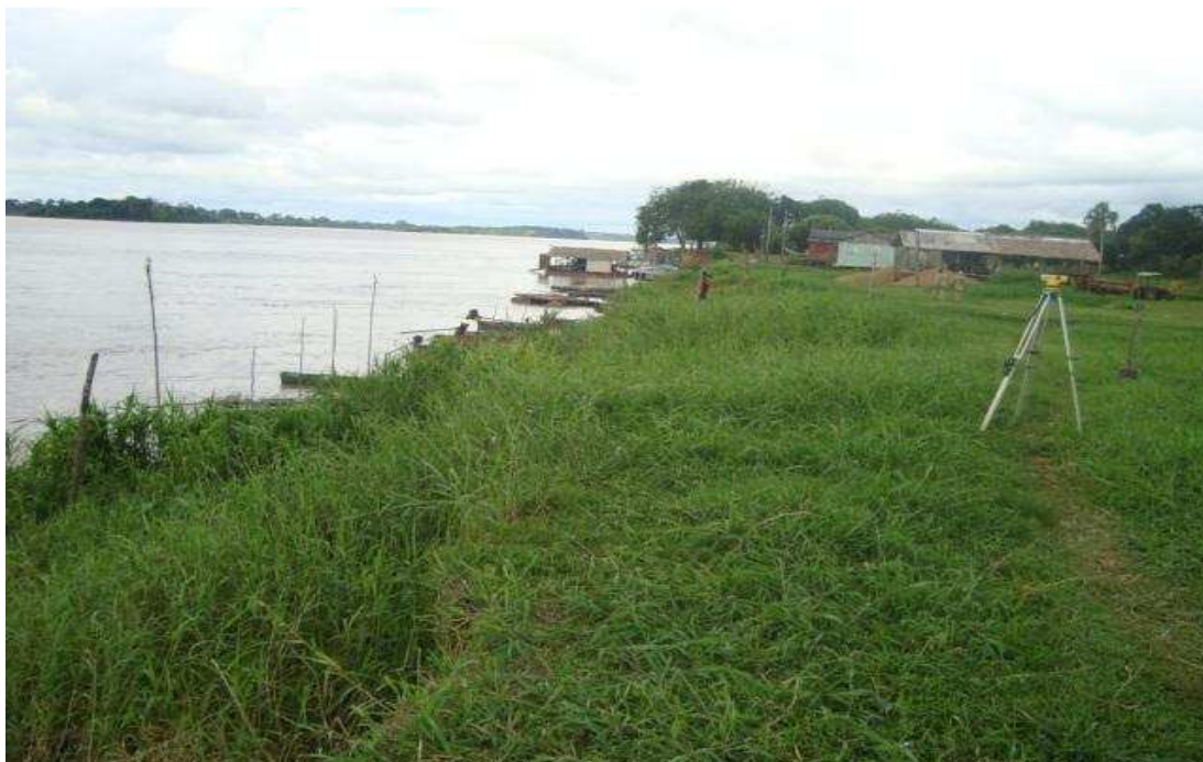
Figura 3.22. Vista Parcial (para montante) da Margem no Local de Monitoramento 9
