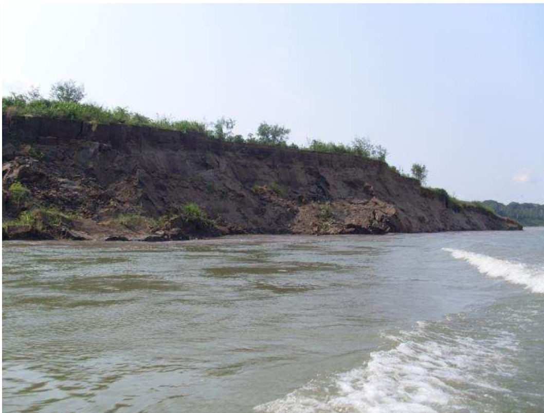
Figura 3.29. Detalhe do Processo Erosivo na Margem Esquerda do Rio Ji-Paraná
