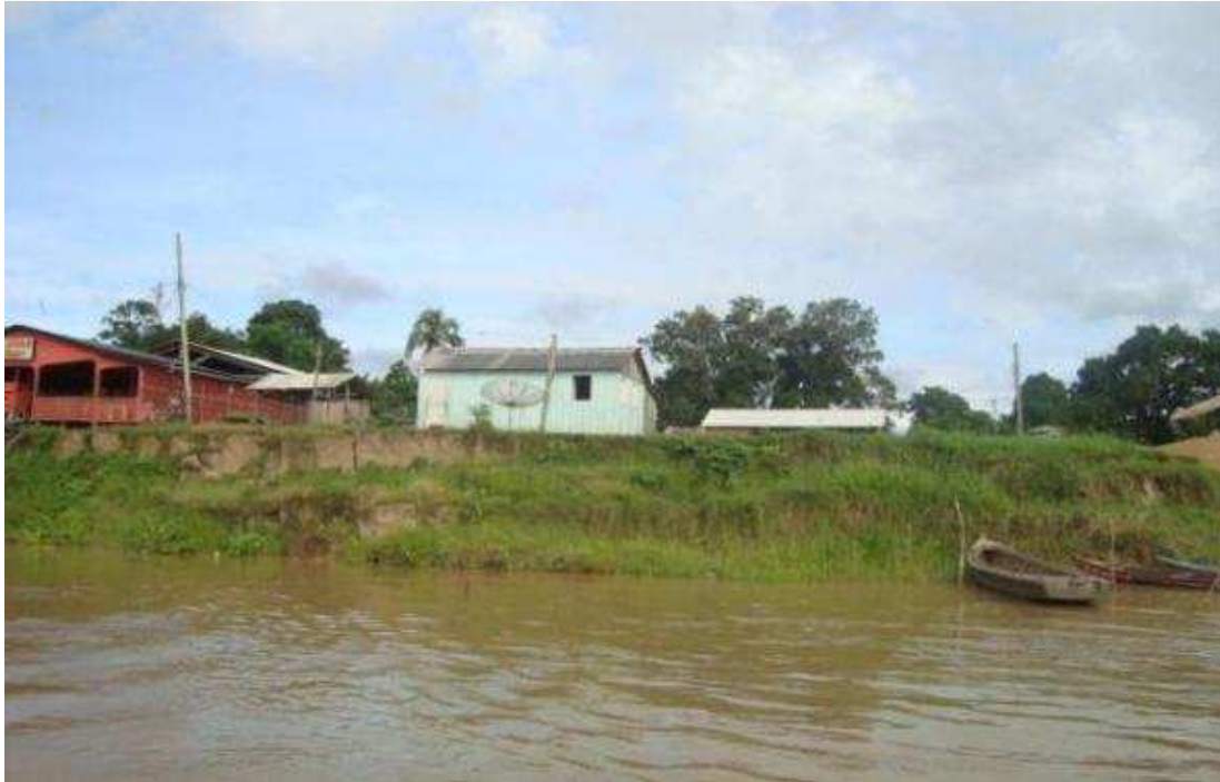
Figura 3.19. Vista Geral da Margem do Local de Monitoramento 8
