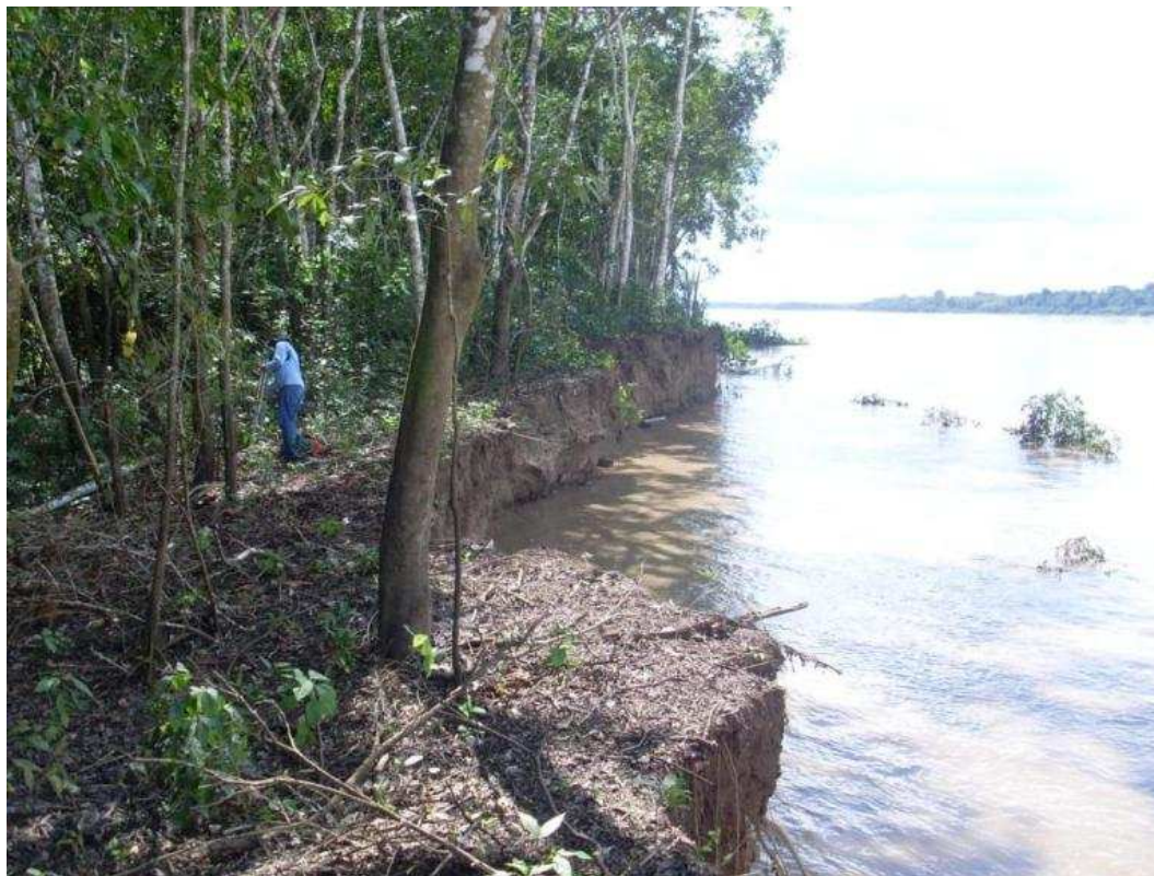
Figura 3.15. Vista Geral da Margem do Local de Monitoramento 6
