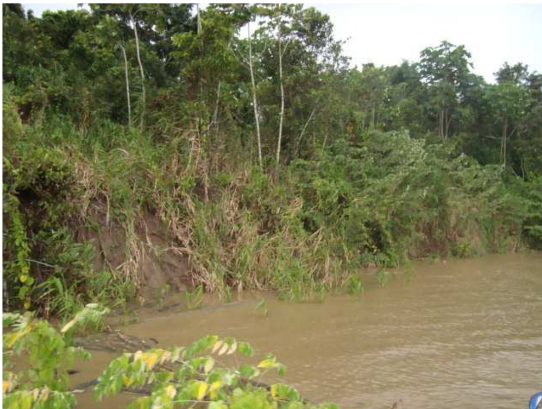
Figura 3.36. Detalhe da Margem do Rio Madeira no Local de Monitoramento 16
