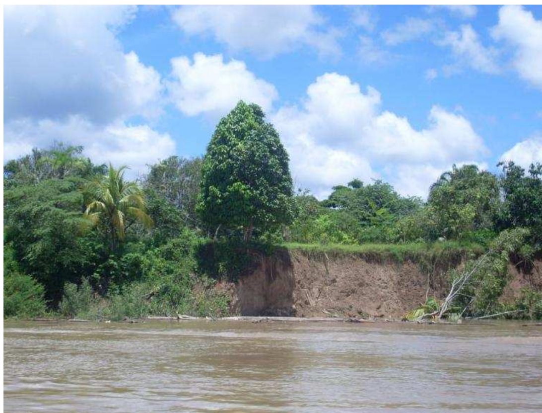
Figura 3.7. Vista Geral da Margem do Local de Monitoramento 3
