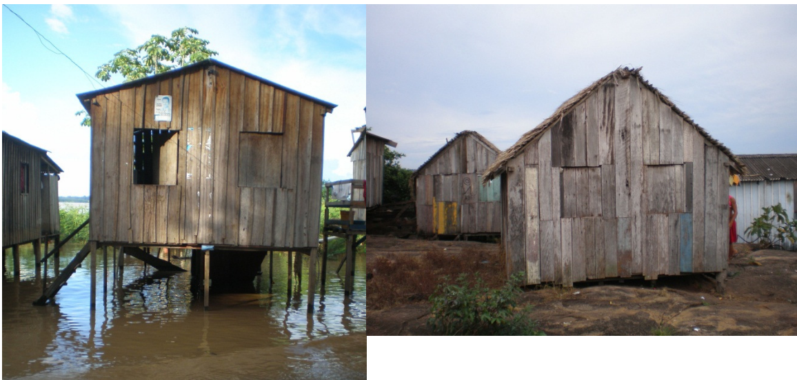
Fotos 1 e 2 – Edificações de madeira que se localizavam, respectivamente, nos povoados de Cachoeira do Teotônio e Amazonas.
