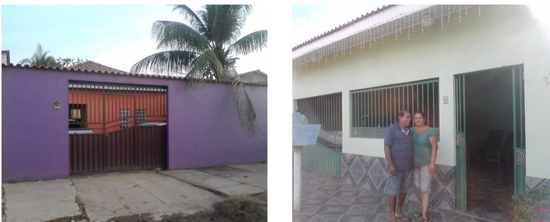
Fotos 3 e 4 – Edificações de alvenaria localizadas em Porto Velho.
