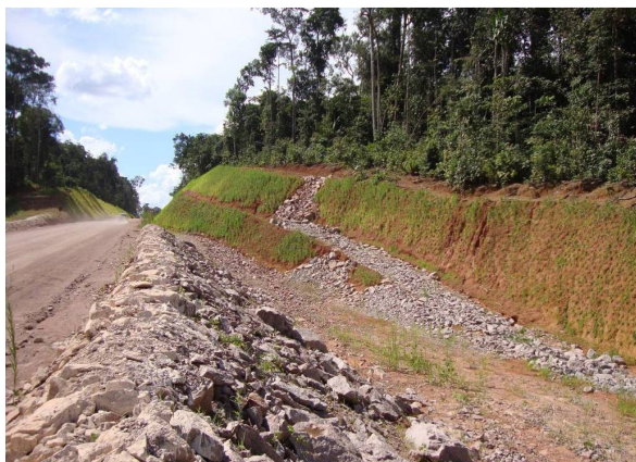
Foto 3: Estabilização nos pontos de lançamento de drenagem e nos bueiros onde o acesso intercepta cursos d'água no AMD 08, com a utilização de enrocamento
