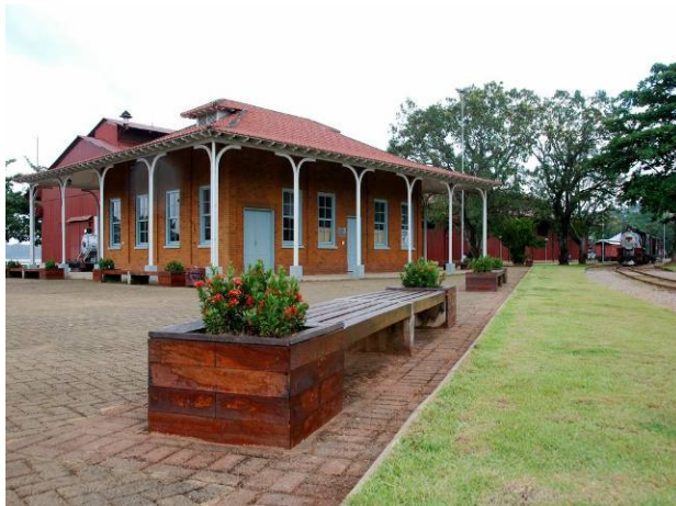
Foto 2: Estação Ferroviária após o restauro
