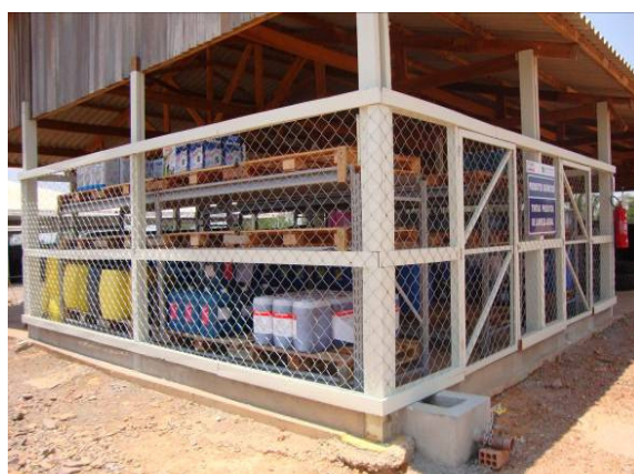
Foto 6: Implantação de baia de contenção de produtos químicos.
