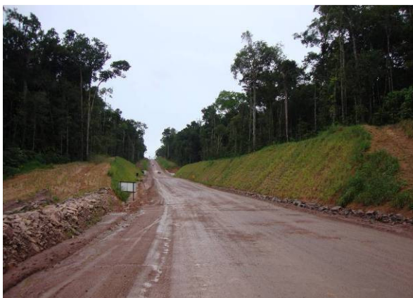
Foto 1: Revegetação dos taludes do acesso AMD 08
