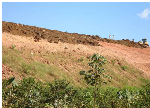
Foto 2: Reconformação do talude do bota fora
