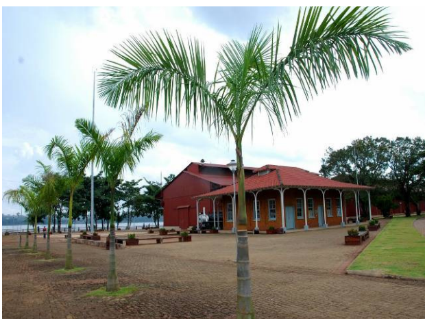
Fotos 3: Estação ferroviária e Galpão II
