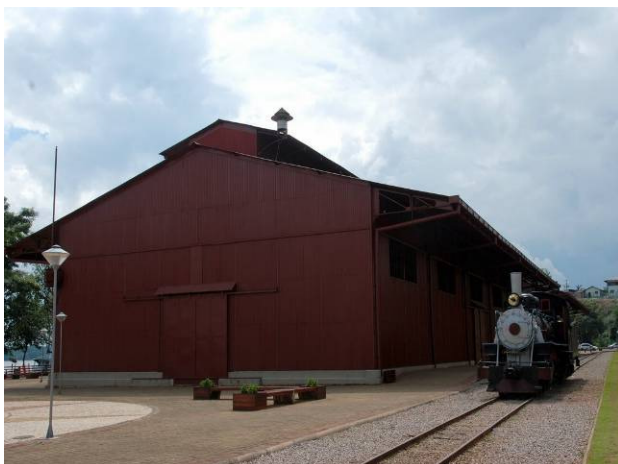
Foto 7: Galpão II restaurado
