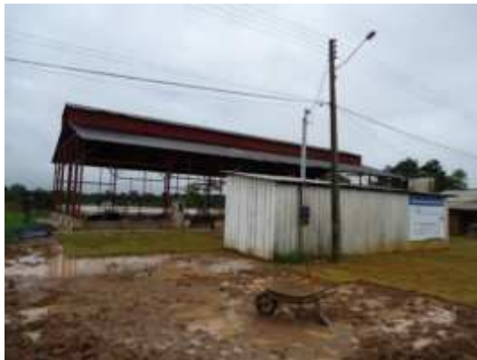
Foto 11 - Recuperação do Galpão Metálico da EFMM em Abunã - 29/02/12
