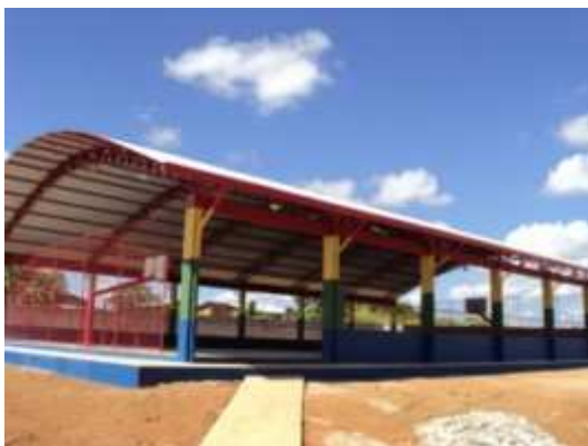
Foto 41 - Construção Quadra Poliesportiva de Extrema - 20/06/11
