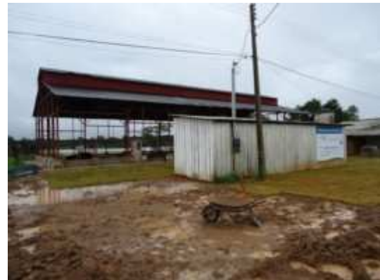
Foto 12 - Recuperação do Galpão Metálico da EFMM em Abunã - 29/02/12
