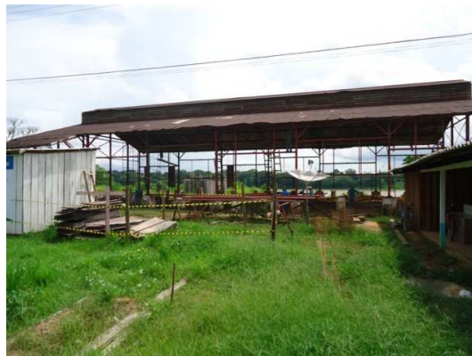
Foto 26 - Recuperação Galpão EFMM em Abunã - 21/12/11
