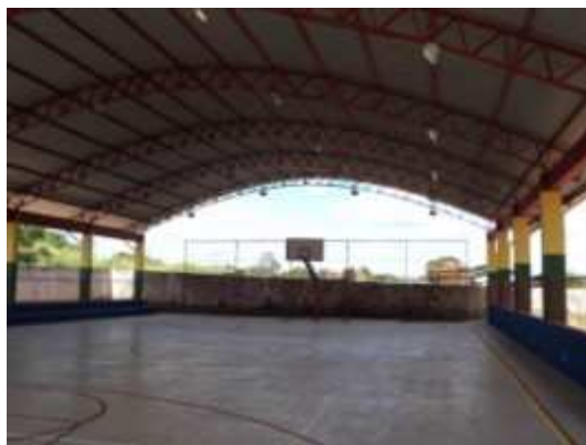
Foto 42 - Construção Quadra Poliesportiva de Extrema - 20/06/11
