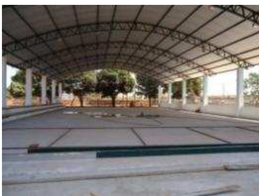
Foto 39 - Construção de Quadra de Vista Alegre - 26/07/11
