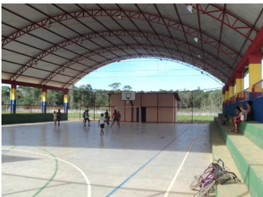
Foto 29 - Construção Quadra Poliesportiva em Abunã - 22/11/11
