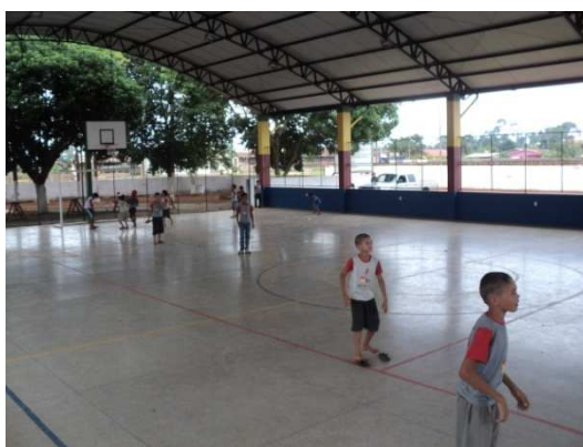
Foto 40 - Construção de Quadra de Vista Alegre - 26/07/11
