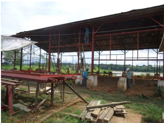
Foto 25 - Recuperação Galpão EFMM em Abunã - 21/12/11
