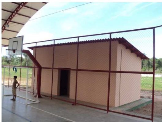
Foto 30 - Construção Quadra Poliesportiva em Abunã - 22/11/11
