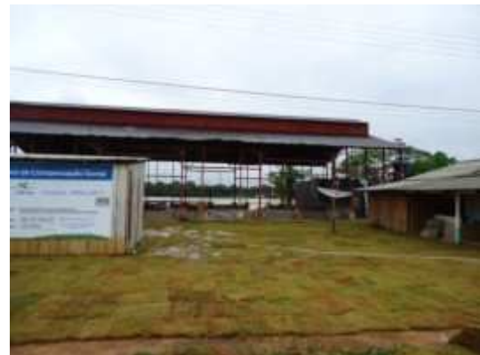
Foto 10 - Recuperação do Galpão Metálico da EFMM em Abunã - 29/02/12
