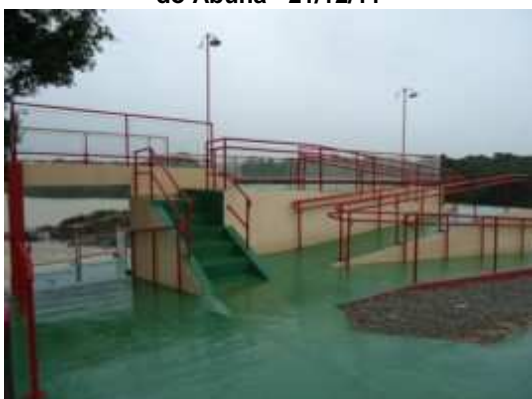
Foto 33 - Construção do Mirante de Fortaleza do Abunã - 27/01/12
