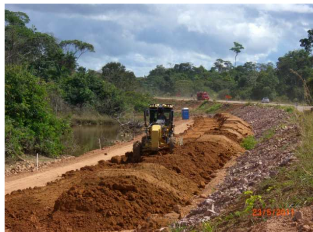
Foto 7.18 – Espalhamento de material no local do aterro
