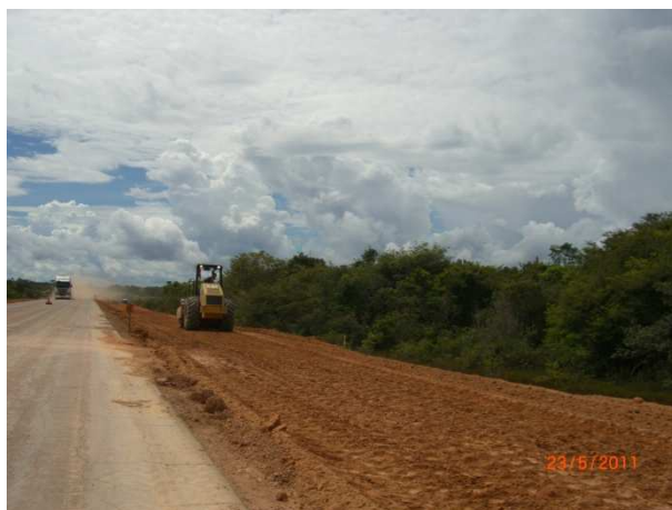
Foto 7.20 – Compactação do material de aterro
