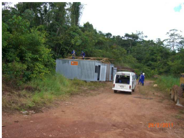
Foto 11.1 – Instalação do canteiro da Benapar distante a 200 metros do igarapé 154 (fev/2011)
