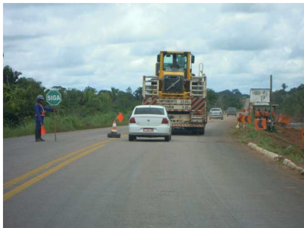
Foto 5.1 – Desvio localizado e provisório na BR-364, início das obras (fev/2011)
