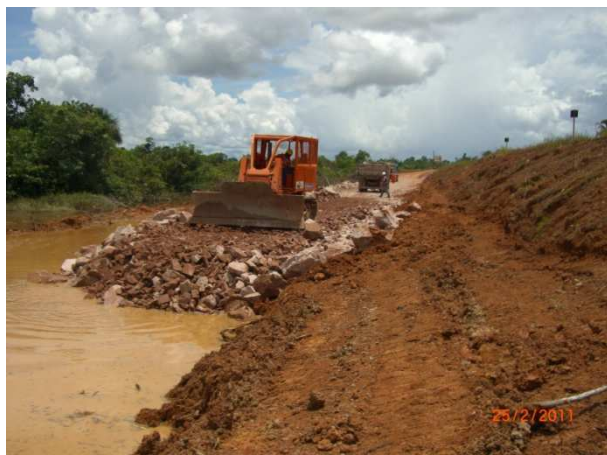
Foto 7.11 – Transporte e aplicação de rachão para preenchimento de cavas inundadas
