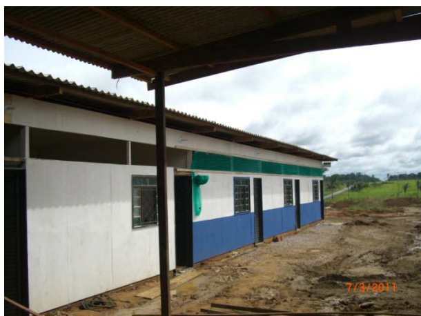
Foto 7.5 – Instalação do alojamento no canteiro de obras da Rondônia Transportes.
