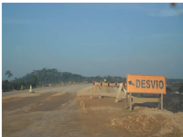
Foto 5.5 – Sinalização vertical indicativa no desvio na BR-364 (março/2011)
