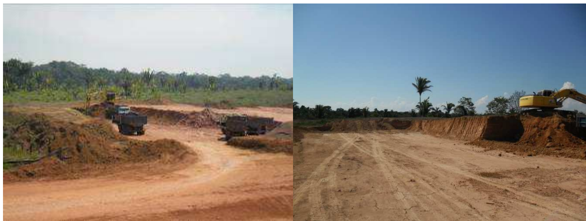
Figura 05: Atividades de extração de cascalho laterítico na Jazida
