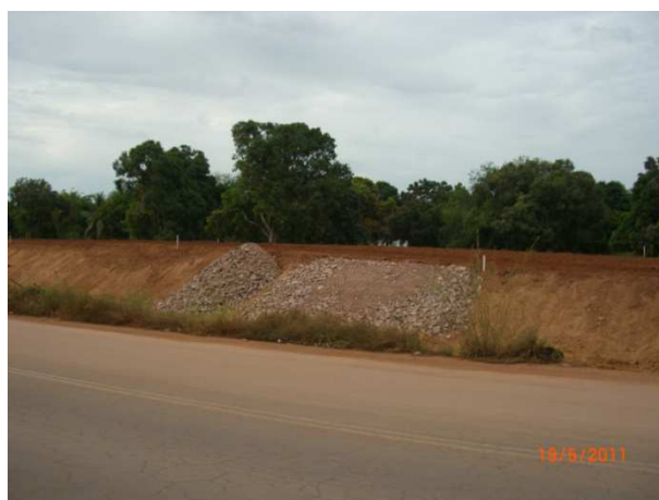
Foto 7.22 – Teste para a aplicação do enrocamento com rachão para proteção dos taludes
