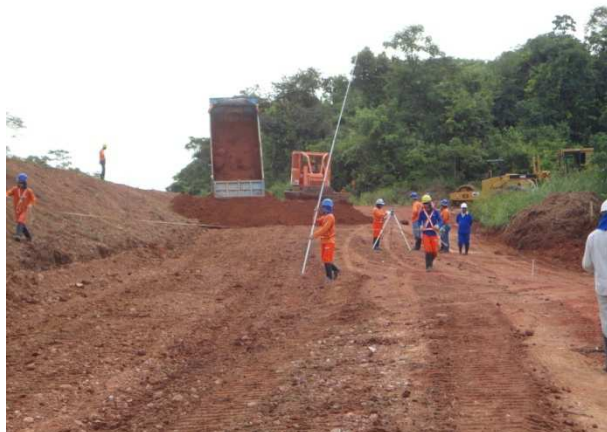
Foto 7.9 - Demarcações planialtimétricas com a equipe de topografia
