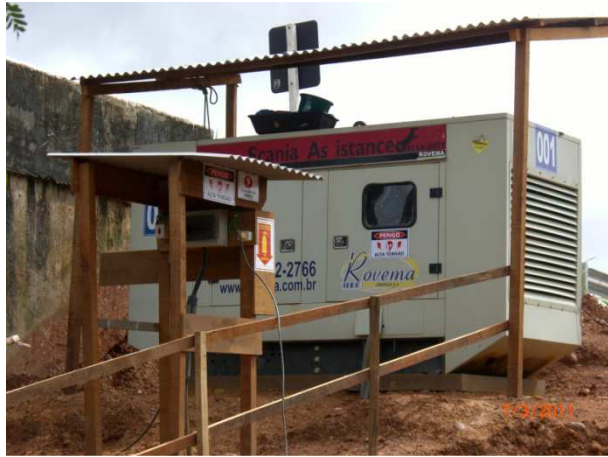
Foto 11.7 – Instalação do gerador de energia (março/2011)
