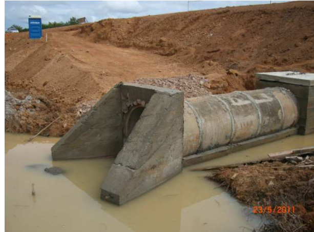
Foto 7.14 – Ampliação dos bueiros do sistema de drenagem.
