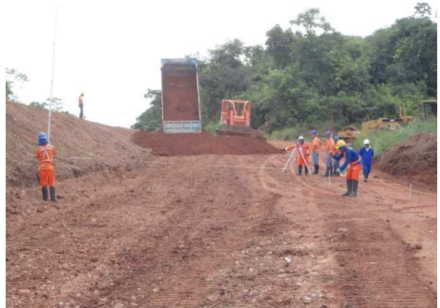
Foto 7.10 – Demarcações planialtimétricas com a equipe de topografia
