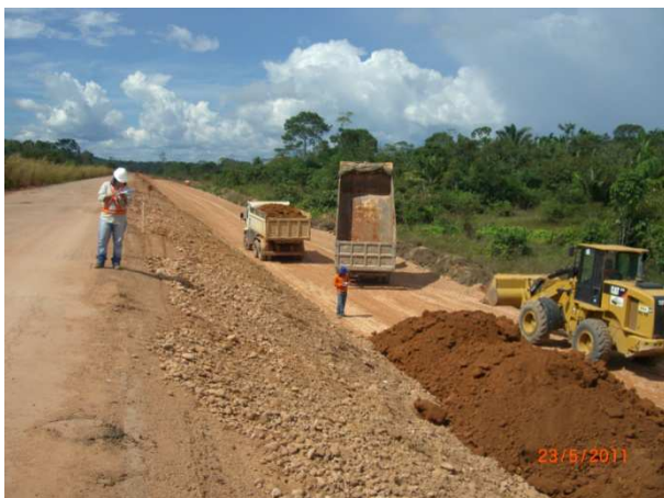
Foto 7.17 – Lançamento de material no local do aterro
