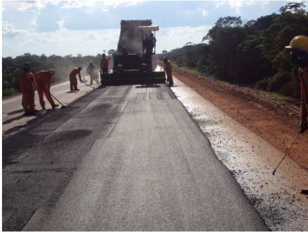
Foto 7.24 – Lançamento de CBUQ
