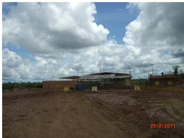
Foto 7.2 – Início da construção das instalações no canteiro de obras da Rondônia Transportes
