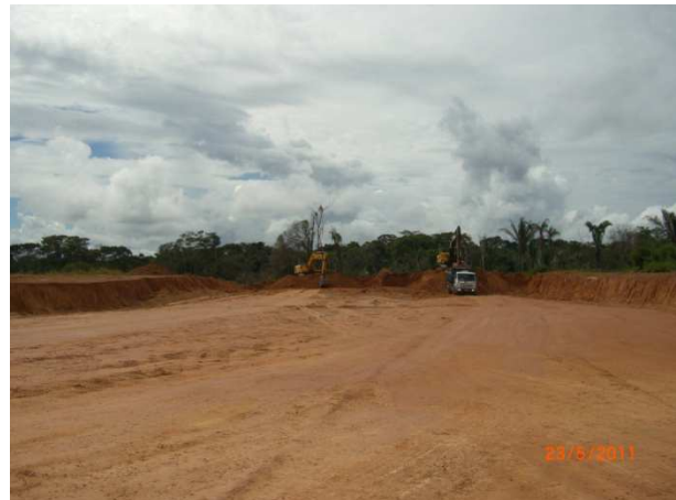
Foto 7.16 – Retirada de material de primeira categoria das jazidas.
