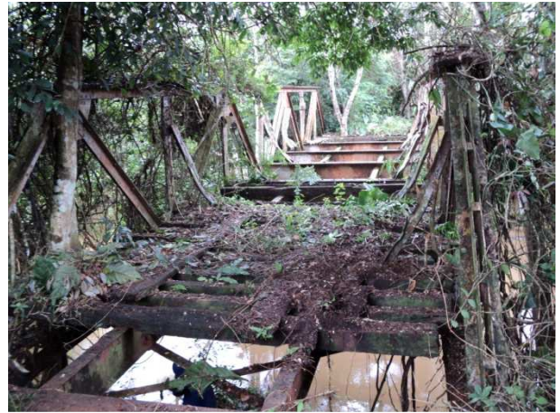
Foto 11.8 – Ponte ferroviária sobre o igarapé 154 antes das obras de recuperação (fev/2011)
