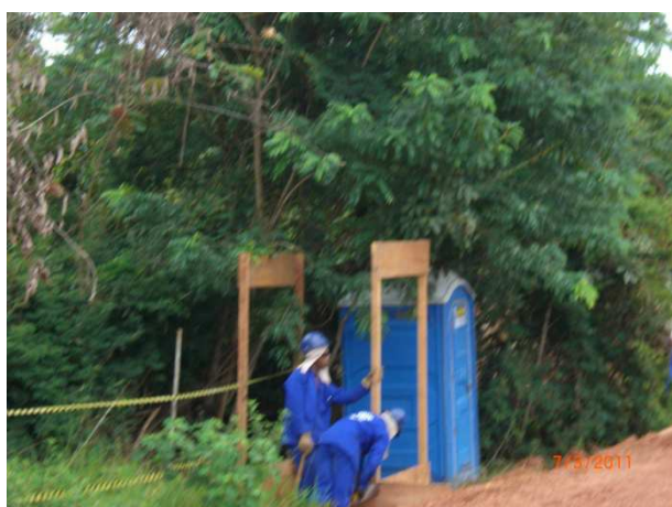
Foto 11.5 – Instalação dos banheiros químicos no canteiro da Benapar (março/2011)
