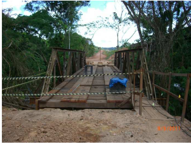
Foto 11.13 – Reforço da estrutura da ponte ferroviária (maio/2011)
