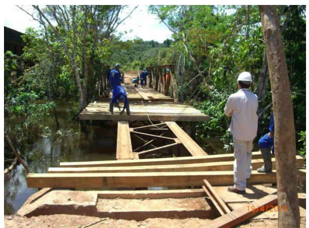
Foto 11.12 – Reforço da estrutura da ponte ferroviária (abril/2011).
