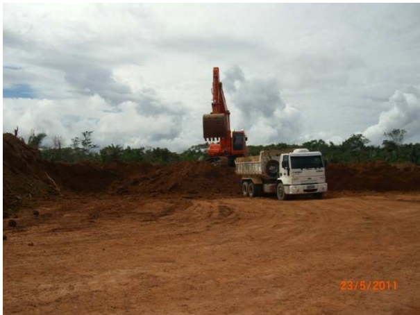
Foto 7.15 – Retirada de material de primeira categoria das jazidas.
