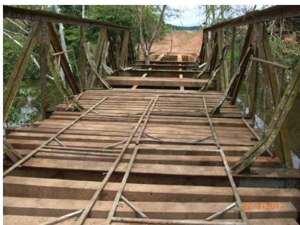
Foto 11.11 – Reforço da estrutura da ponte ferroviária (março/2011).
