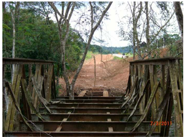
Foto 11.10 – Limpeza vegetal e preparação para recuperação da ponte ferroviária (março/2011)
