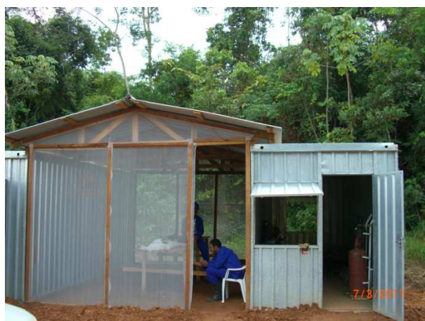
Foto 11.4 – Instalação concluída do canteiro da Benapar com contêineres e área de vivência (março/2011)
