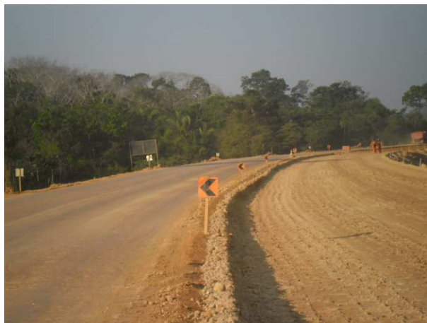
Foto 5.2 – Desvio localizado e provisório na BR-364. Em trecho com terraplenagem (Março/2011)
