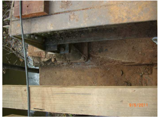
Foto 11.14 – Reforço da travessa de concreto armado (maio/2011)
