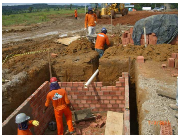
Foto 7.6 – Instalação do sistema de tratamento de esgoto sanitário no canteiro de obras da Rondônia Transporte .
