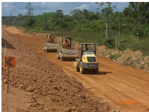
Foto 7.19 – Compactação do material de aterro
