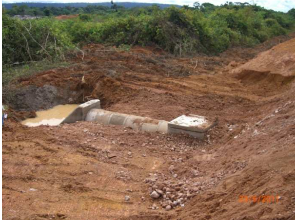
Foto 7.13 – Ampliação dos bueiros do sistema de drenagem
