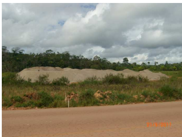
Foto 7.21 – Depósito de brita graduada a ser utilizada na base do pavimento
