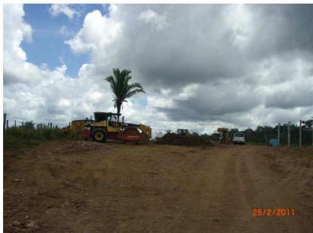
Foto 7.1 – Início da terraplenagem no canteiro de obras da Rondônia Transportes
