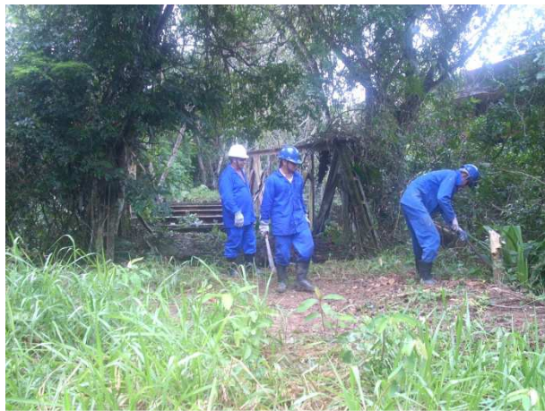
Foto 11.9 – Limpeza vegetal na ponte ferroviária sobre igarapé 154 (fev/2011)
