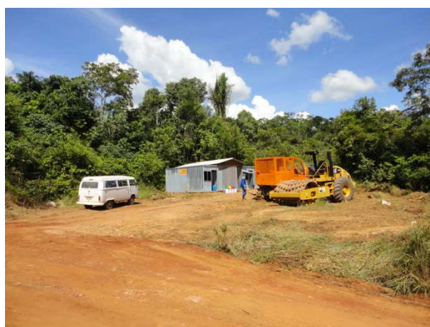
Foto 11.6 – Vista geral do canteiro da Benapar (março/2011).
