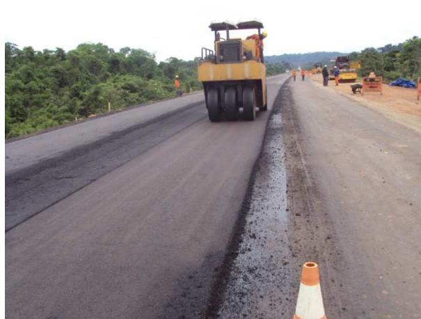
Foto 7.23 – Compactação capa de rolamento (CBUQ)
