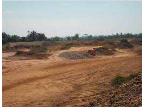
Figura 05: Atividades de extração de cascalho laterítico na Jazida
