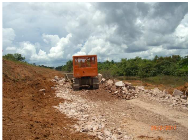
Foto 7.12 – Transporte e aplicação de rachão para preenchimento de cavas inundadas
