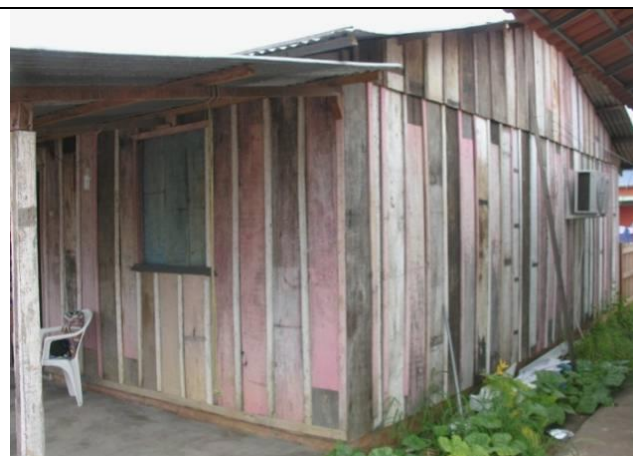
FIGURA 15: Construção de casa de madeira, residência do beneficiado Manoel Luz. Rua Getúlio Vargas, Qd. O1, Lt. 17.
