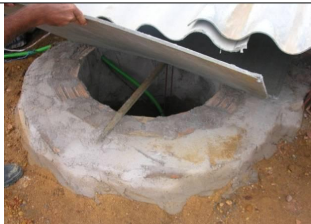
FIGURA 32: Poço construído na propriedade do beneficiado Francisco Xavier de Paula Silva.
