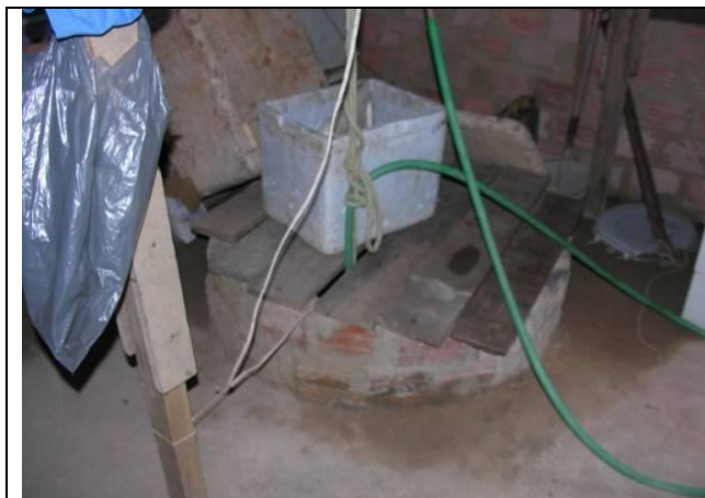
FIGURA 8: Poço construído na propriedade da beneficiada Gilcineia de N. Soares. Rua Chiquilito Erse, Qd. N1, Lt. 18.
