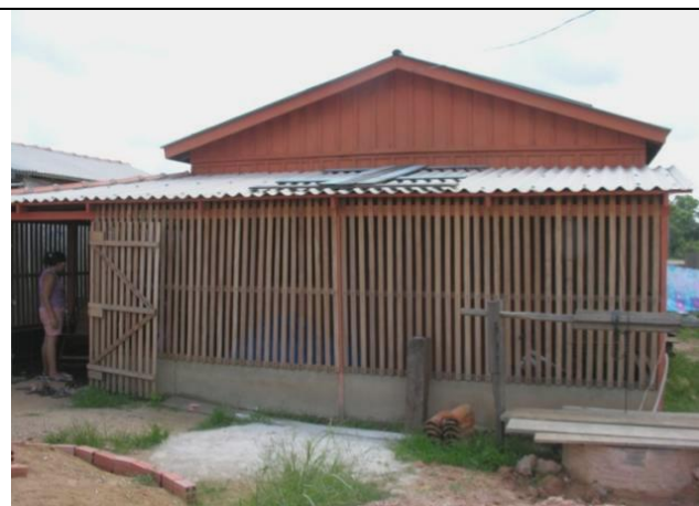
FIGURA 2: Imóvel residencial na Comunidade Jirau. Beneficiada Maria Alda de Lima Costa.
