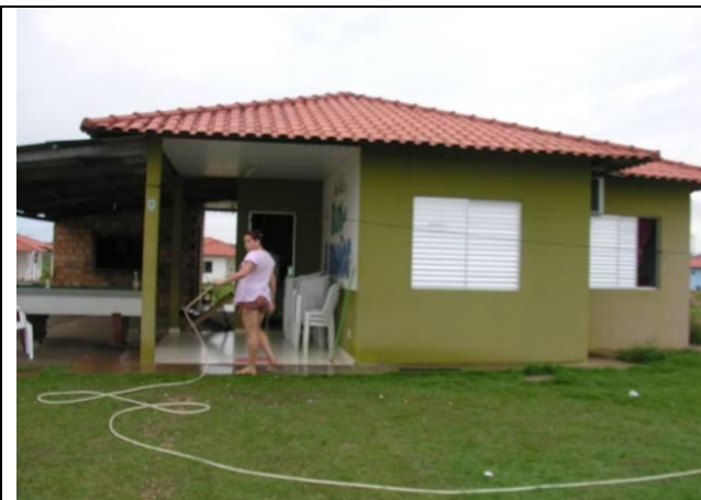
FIGURA 12: Adaptação do imóvel em bar pela beneficiada Valdilene Pereira Lima. Rua Getúlio Vargas, Qd. P1, Lt., 04.
