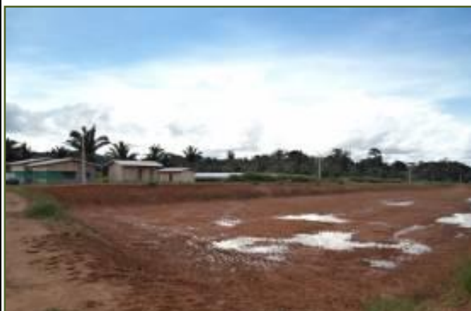
Abertura de rampa para compactação do tanque de engorda - Vista do Acesso
