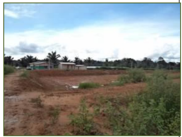
Abertura de rampa para compactação do tanque de engorda - Vista do Acesso
