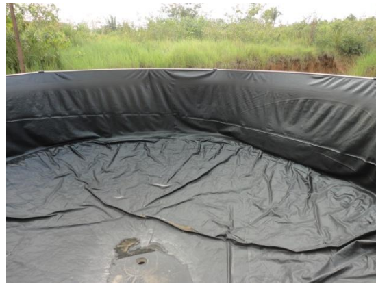
Foto 06- Visita técnica a projeto de piscicultura – propriedade da BIOFISH Aqüicultura- Porto Velho. Detalhes do revestimento dos tanques- 27-2-2012
