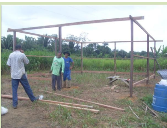
RRC - 34 Maria Pessoa Botelho - acompanhamento da construção da residência- janeiro de 2011
