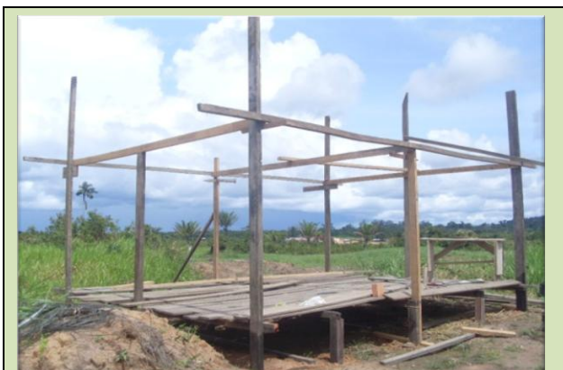
RC-18 Ivo Rodrigues Pereira – construção de moradia - janeiro de 2011
