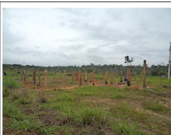
Foto 3 – RRC-16 FRANCINETE ARAUJO DE SOUZA, 04/02/2012. Verificação da construção do curral.
