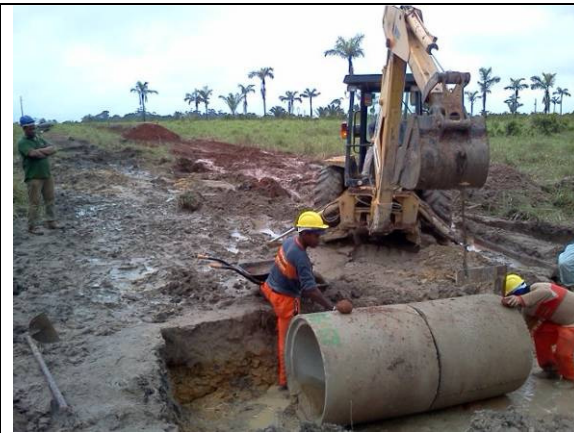
BUEIRO NOS ACESSOS
