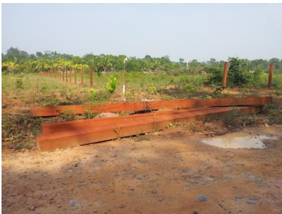
Construção das Cercas
