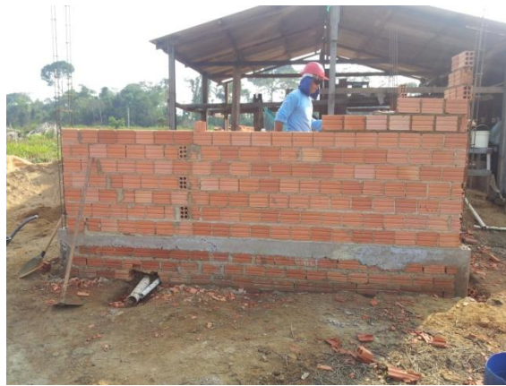
Galpão – Levantamento da Alvenaria
