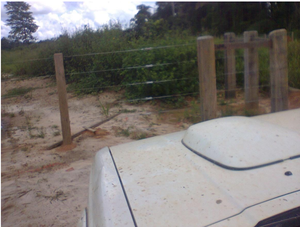
Lote 11 - Detalhe da Cerca, Mourões de Canto e Seccionamento
