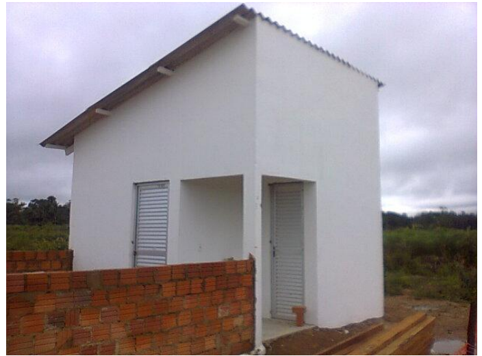
Lote 02 – Galpão com ampliação do Proprietário
