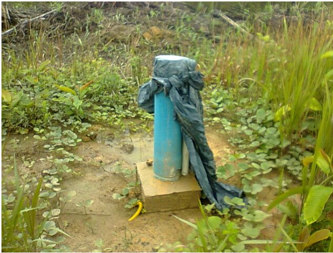
Lote 2 – Poço Tubular
