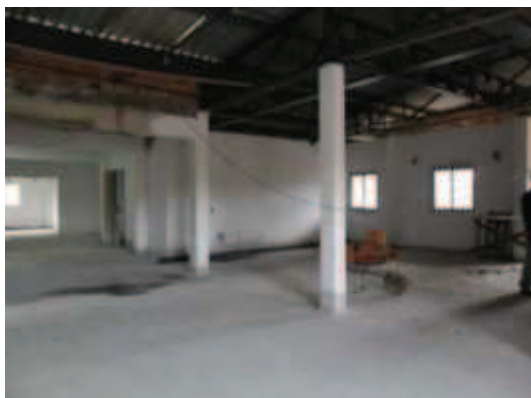
Foto 25 - Construção UPA Zona Leste - 29/02/12
