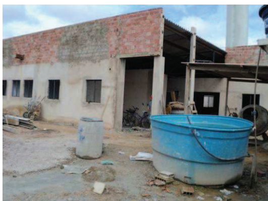
Foto 21 - Construção UPA Zona Leste - 29/12/11
