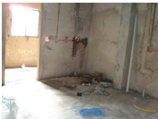
Foto 22 - Construção UPA Zona Leste - 29/12/11
