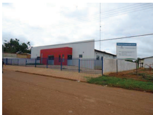
Foto 6 - Construção UBS Extrema - 21/12/11
