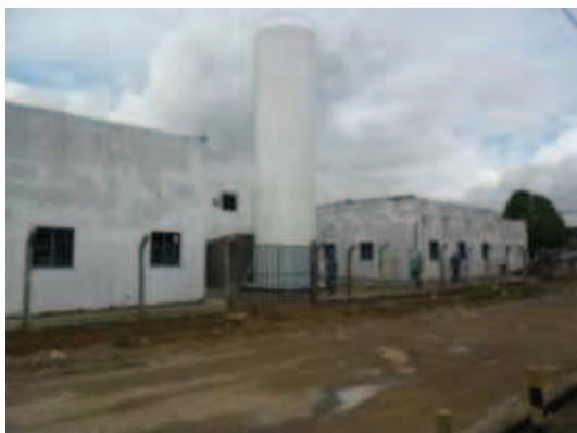
Foto 19 - Construção UPA Zona Sul - 29/02/12
