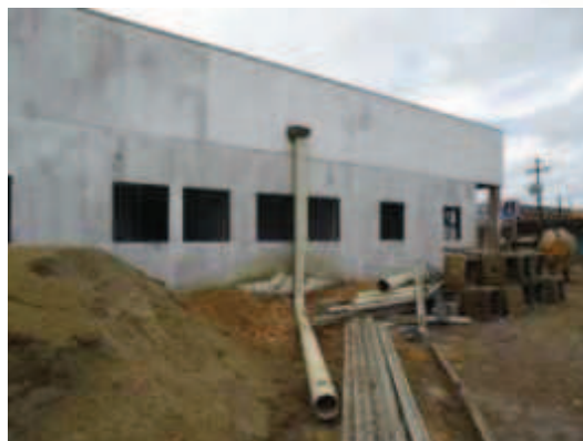
Foto 26 - Construção UPA Zona Leste - 29/02/12
