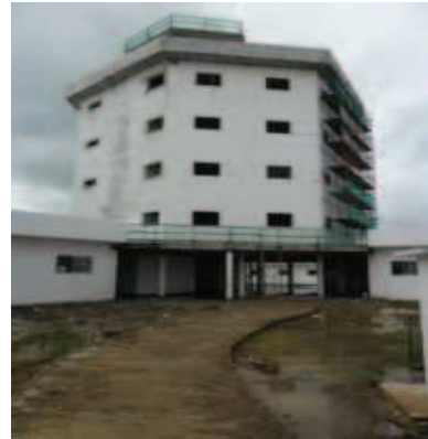
Foto 14 - Construção Policlínica Oswaldo Cruz- 29/02/12
