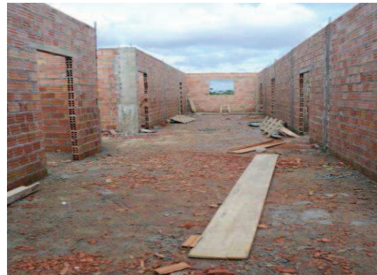
Foto 16 - Construção UPA Zona Sul - 29/12/11
