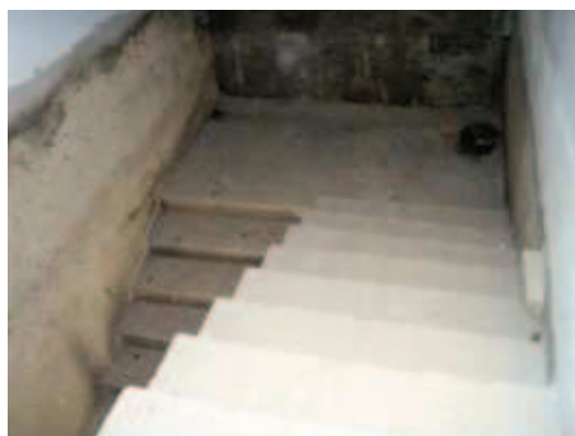
Foto 24 - Construção UPA Zona Leste - 27/01/12
