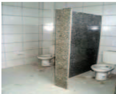
Foto 11 - Construção Policlínica Oswaldo Cruz - 27/01/12
