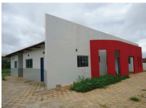
Foto 5 - Construção UBS Extrema - 21/12/11
