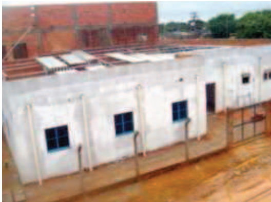
Foto 17 - Construção UPA Zona Sul - 27/01/12
