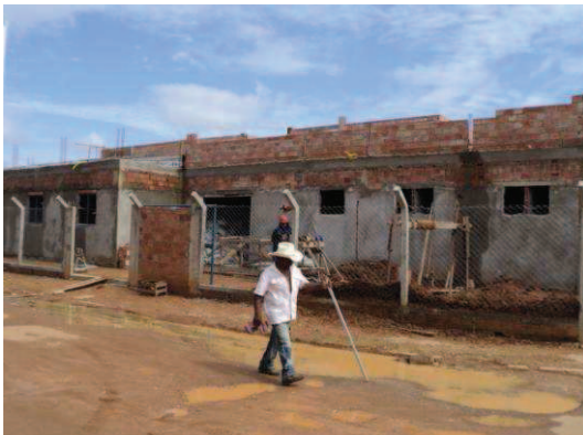
Foto 15 - Construção UPA Zona Sul - 29/12/11
