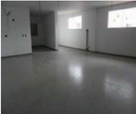
Foto 13 - Construção Policlínica Oswaldo Cruz- 29/02/12
