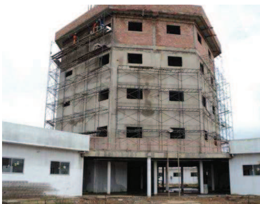
Foto 9 - Construção Policlínica Oswaldo Cruz - 29/12/11
