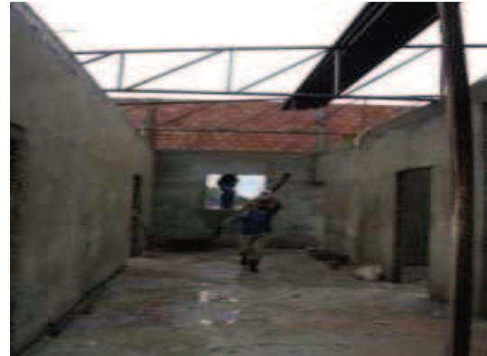
Foto 18 - Construção UPA Zona Sul - 27/01/12
