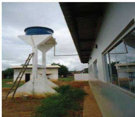
Foto 8 - Construção UBS Extrema - 21/12/11
