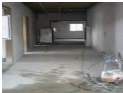
Foto 20 - Construção UPA Zona Sul - 29/02/12
