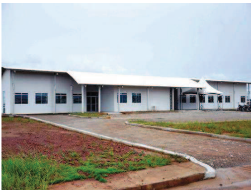
Foto 1 - Construção UBS Nova Mutum Paraná - 21/12/11
