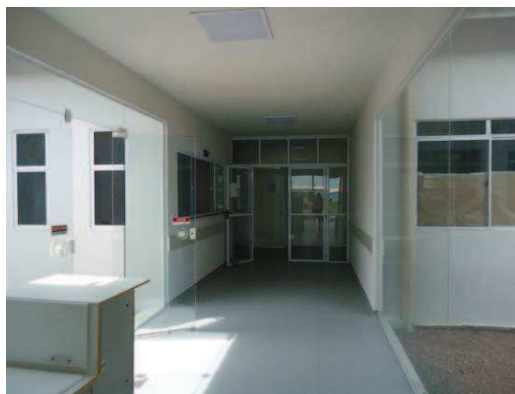
Foto 2 - Construção UBS Nova Mutum Paraná - 21/12/11
