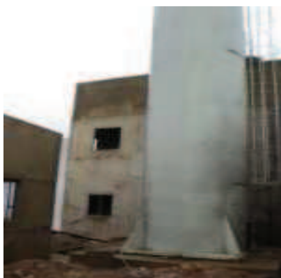
Foto 23 - Construção UPA Zona Leste - 27/01/12
