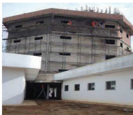
Foto 10 - Construção Policlínica Oswaldo Cruz - 29/12/11
