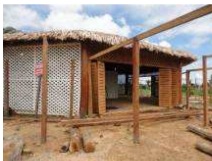
Foto 01 - Vista externa da sede do Observatório Ambiental Jirau
