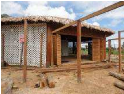
Foto 95 - Vista externa da sede do Observatório Ambiental Jirau
