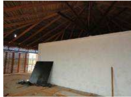
Foto 96 - Vista da área interna
