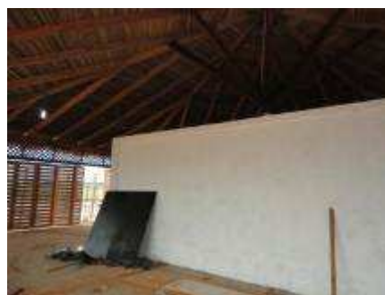
Foto 02 - Vista da área interna
