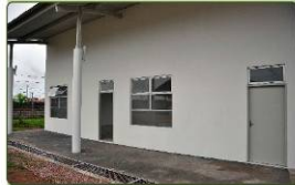
Duas novas salas construídas na Escola Nossa Senhora de Nazaré
