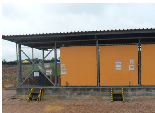
Foto 06- Depósito de Produto Químico
