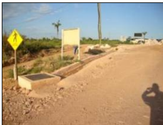
Foto 02: Obras de drenagem definitiva nos acessos
