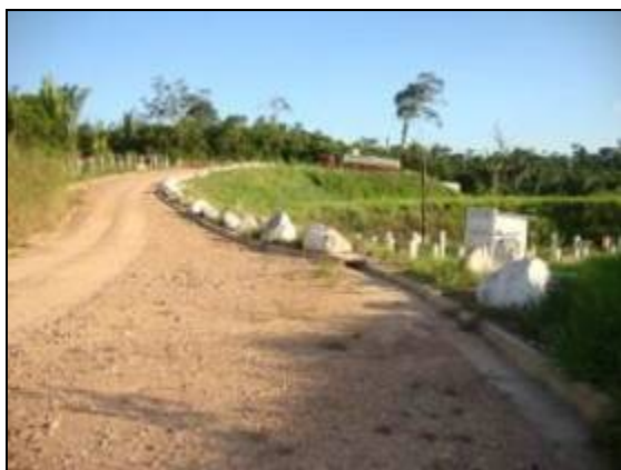
Foto 01: Drenagem definitiva do paiol de explosivos
