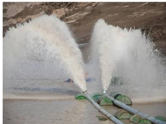
**Figura 5.** Detalhe do retorno de água do rio Madeira para um dos recintos.
