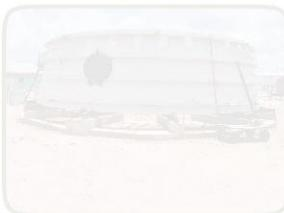
Virolas chinesas Dong Fang da primeira unidade geradora (29) da margem esquerda do rio Madeira estão sendo pré-montadas na Usina Hidrelétrica Jirau. A pré-montagem ocorre na margem direita, no pátio da Enesa, empresa responsável pela montagem eletromecânica. Cada virola Dong Fang pesa 22 toneladas e mede 10 metros de diâmetro.
