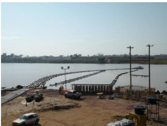
**Figura 2.** Vista geral da tubulação e das bombas de recalque utilizada para a drenagem da água.
