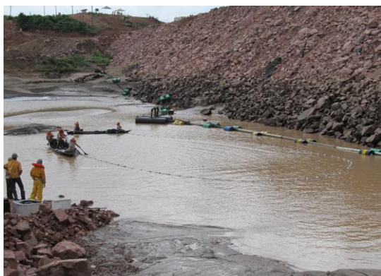
Figura 63. Utilização de rede de cerco para a captura de animais na área das ensecadeiras de desvio do rio Madeira.
