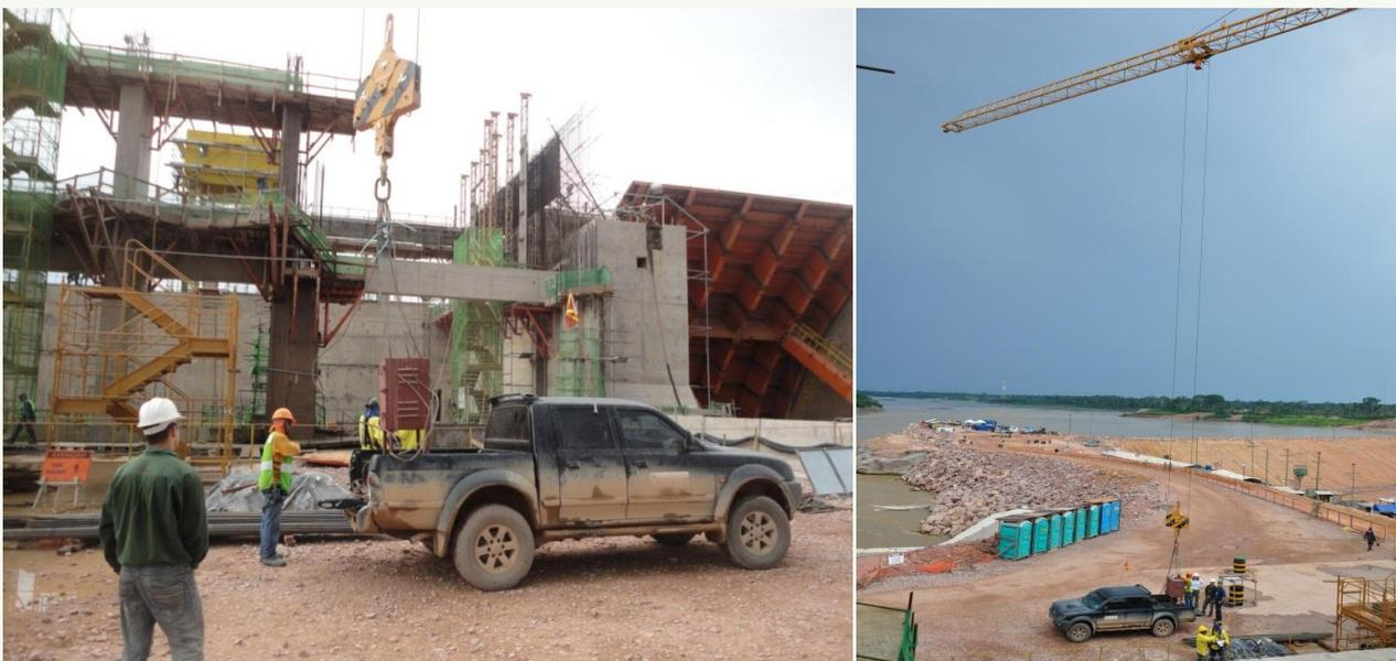
**Figura 1.** Instalação da base fixa n. 6 (montante VTP – margem direita)
