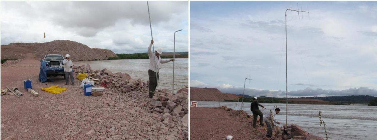
Figura 7. Instalação de antenas aéreas na UHE Jirau (margens direita e esquerda).
