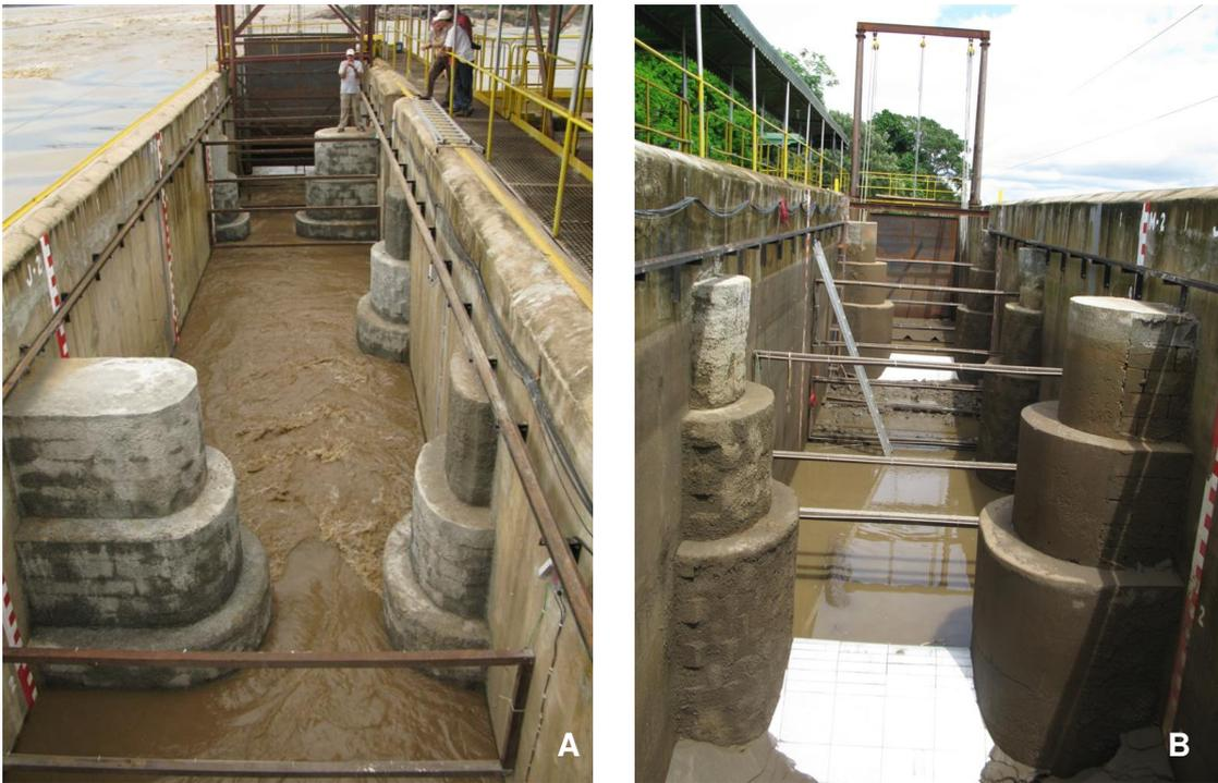
**Figura 4:** Dissipadores construídos no CET em 2011. As molduras de madeiras dão suporte às antenas do SIRF. (A: largura da ranhura de 1,1 m (tratamento 1); B: largura da ranhura de 1,6 m (tratamento 2)).
