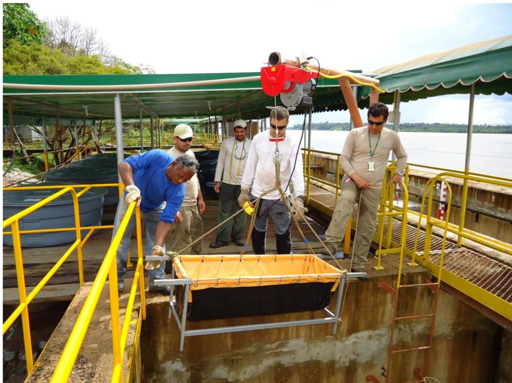
**Figura 10:** Método de soltura dos peixes na área de introdução com auxílio de maca e guincho elétrico. Foto: Luiz Rocha
