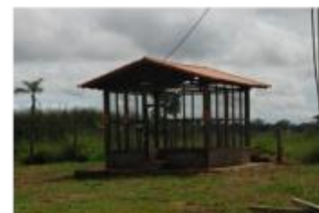
6 - Depósito de Combustíveis
