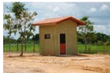
4 – Sala do gerador de energia
