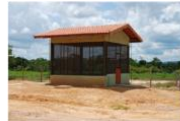
3 – Depósito de Combustíveis
