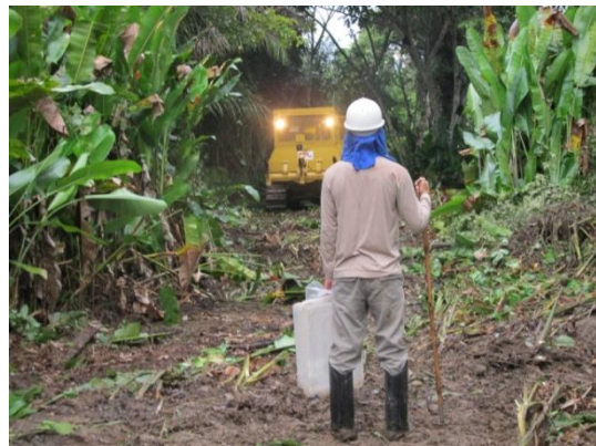
Acompanhamento das atividades de supressão da vegetação na margem direita.
