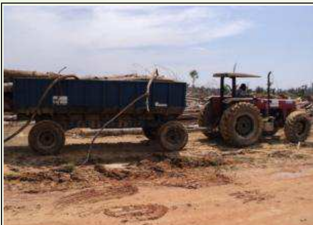
Foto 19 – Arraste de madeira com auxílio de carretão - Lote 1A - Empresa HAZTEC.
