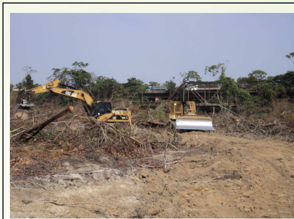
Foto 8 – Abertura de acesso e separação da madeira – Lote 1F – Empresa FOX.
