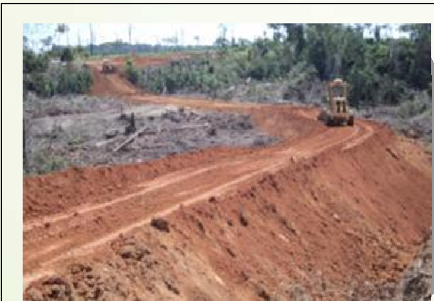
Foto 5 – Construção de aterro – Lote 5C/5D – Empresa CCL.
