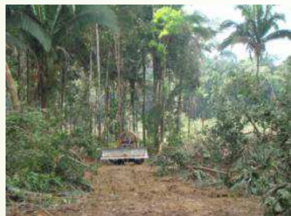
Foto 15 – Trator de esteira realizando bosqueamento – Lote 1A – Empresa HAZTEC.
