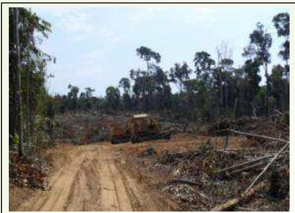
Foto 25 – Atividades de bosqueamento e derrubada – Lote 1E (MD) - Empresa WPG.
